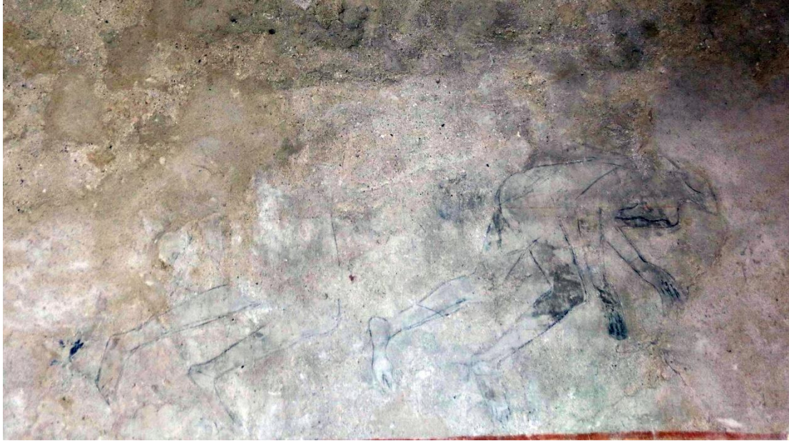
Fig.51. « Salle ronde » du château comtal de Carcassonne, mur ouest partie gauche du mur, détail : deux silhouettes (gisants ?). Photographie : 21/04/2016
