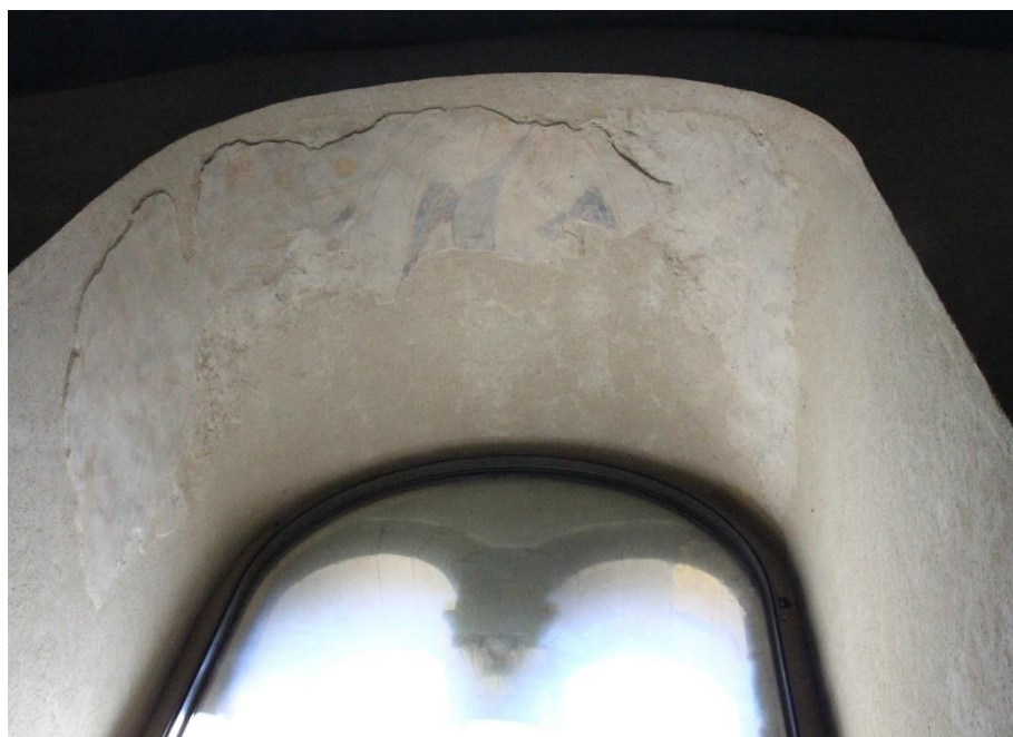
Fig.60. « Salle ronde » du château comtal de Carcassonne, mur est, intrados de la baie. Photographie : 21/04/2016
