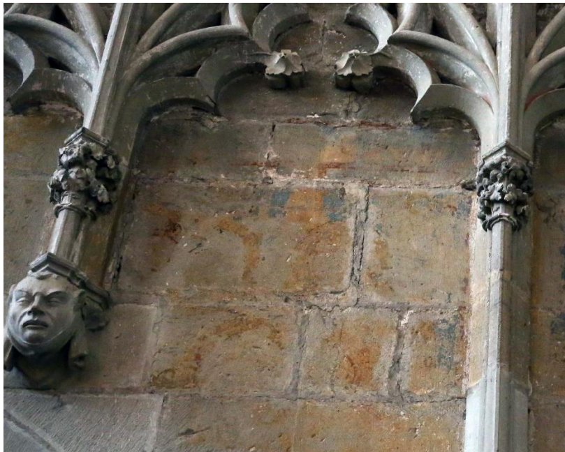
Fig.34. Arcatures méridionales du bras sud de transept de la basilique Saint-Nazaire de Carcassonne. Traces de polychromie, détail. 17/02/2017
