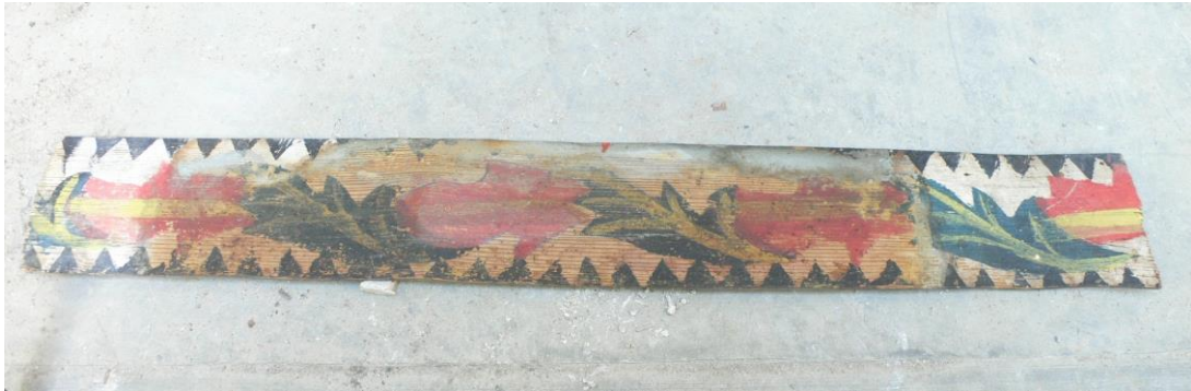
Fig.5. Plafond du 19 rue de Verdun, couvre-joint déposé pour restauration. Photographie : Marie-France Pauly, 2009
