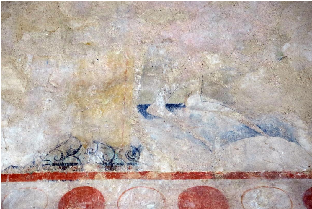
Fig.52. « Salle ronde » du château comtal de Carcassonne, mur ouest partie droite du mur, détail. Photographie : 21/04/2016
