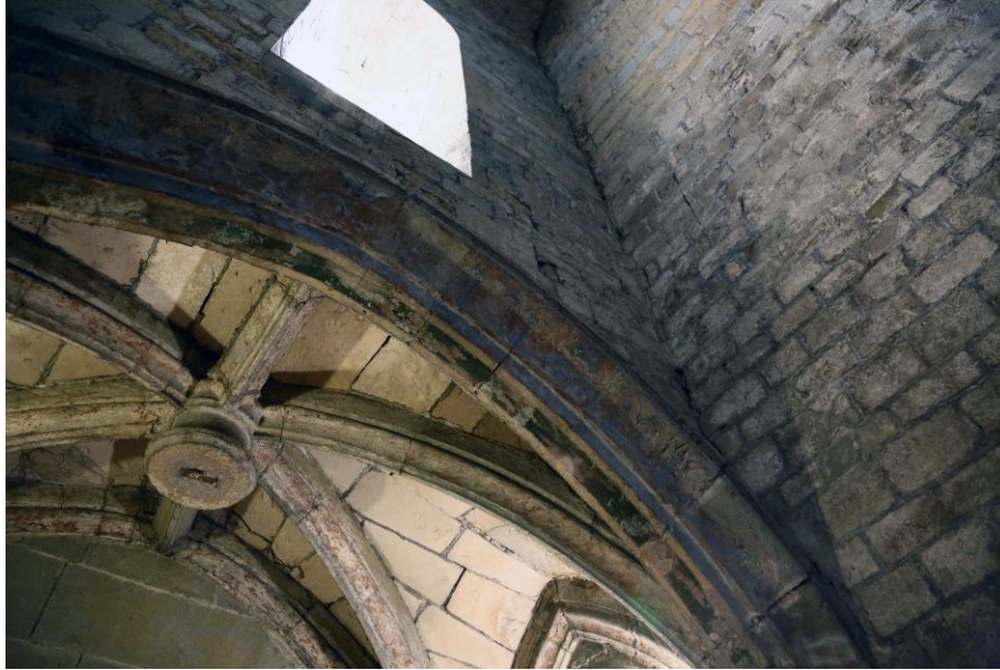
Fig.31. Arcade de la chapelle de la première travée du collatéral sud de la nef de Saint-Nazaire de Carcassonne. Traces de motifs de végétaux. 17/02/2017
