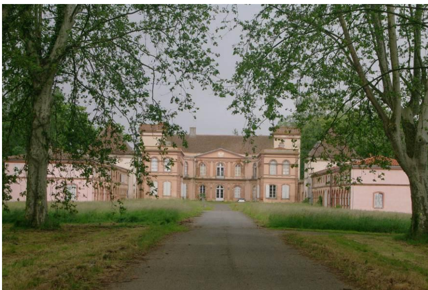
Station 39 : Pinsaguel 3, Le château Berthier
