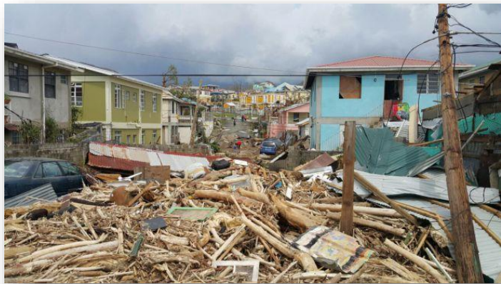
Document 17 : Photo des dégâts provoqués par l'ouragan Maria en 2011 en Guadeloupe
