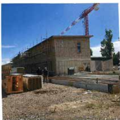
Vue d'ensemble du chantier de l'école élémentaire. 15/09/2021
