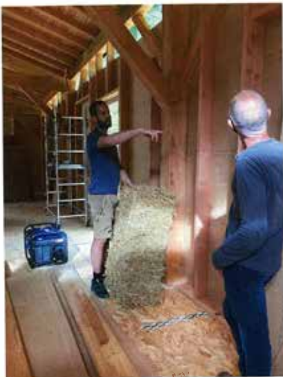
Démonstration de la pose d'une botte de paille dans l'ossature bois.
