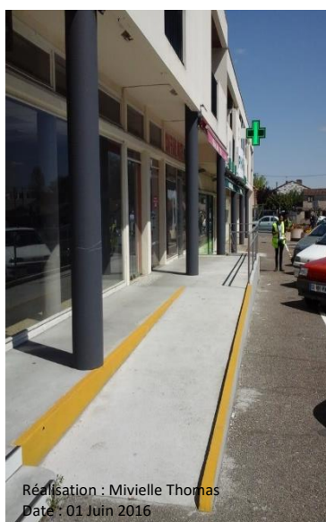
Photo 21 : Centralité du Burck : Aménagement adapté au PMR : rampe, bande d'éveil, nivellement.
