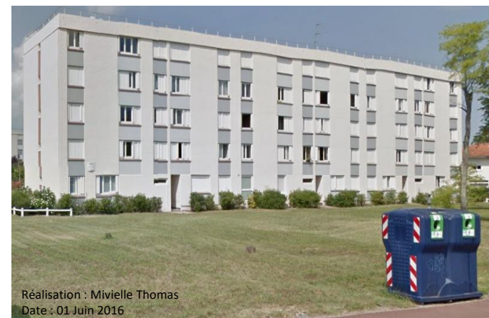
Photo 1 : Immeuble au nord du quartier
