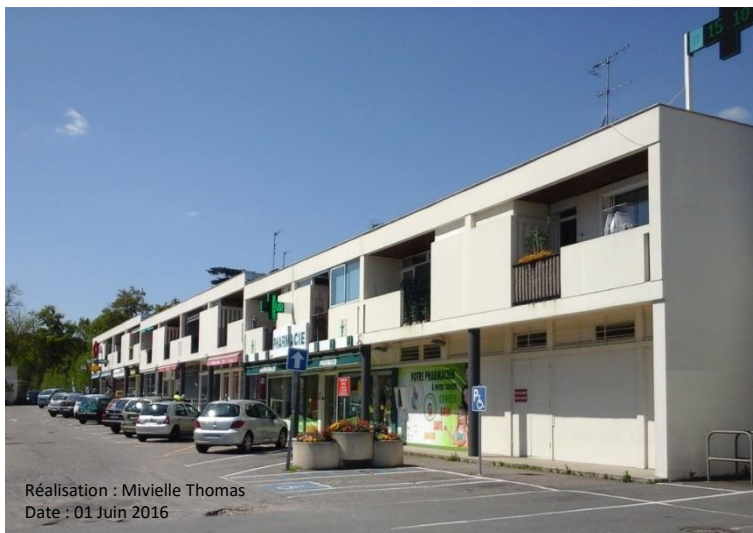
Photo 20 : Commerces linéaires peu esthétiques mais très fonctionnels situés à la centralité du Burck
