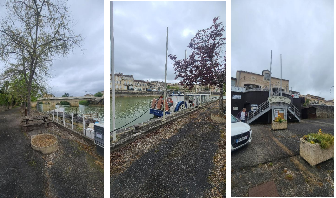
Figure 48: À gauche la partie nord du quai du port de Condom avec au second plan une vue sur le deuxième pont délimitant le port, on relève aussi la présence d'une table de pique-nique qui est la seule sur la totalité du port. Au milieu nous apercevons le bateau organisant des croisières le long de la Baïse : « Le D'Artagnan ». À droite la capitainerie de Condom ainsi que l'espace d'accueil réservé aux clients désireux de faire une croisière sur « Le D'Artagnan ».
