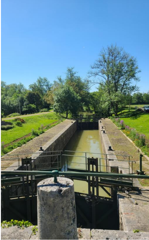
Figure 44: Vue sur la partie sud de la double écluse
