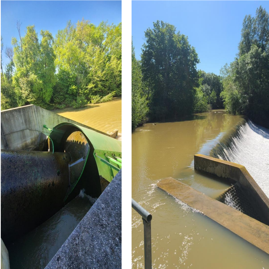
Figure 6 : Centrale hydroélectrique avec sa turbine (à gauche) et son barrage (à droite), 29/04/2025, crédits : Pierre Peuch-Lestrade
