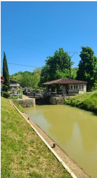
Figure 33: écluse de Gauge, 05/06/2025 crédits: Pierre Peuch-Lestrade
