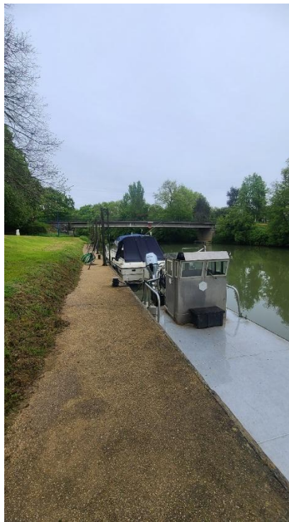
Figure 36: Vue sur la partie du sud du quai du port de Valence-sur-Baïse avec la présence au premier plan de la barge d'entretien du Conseil Départemental Gersois et au second plan le pont symbolisant la fin de la zone navigable
