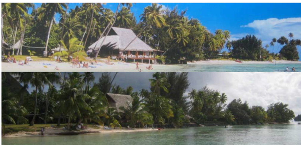
Fig. 57 : Exemple d'érosion littorale sur un hôtel de Moorea entre 1980 et 2009. Source image : inconnue
