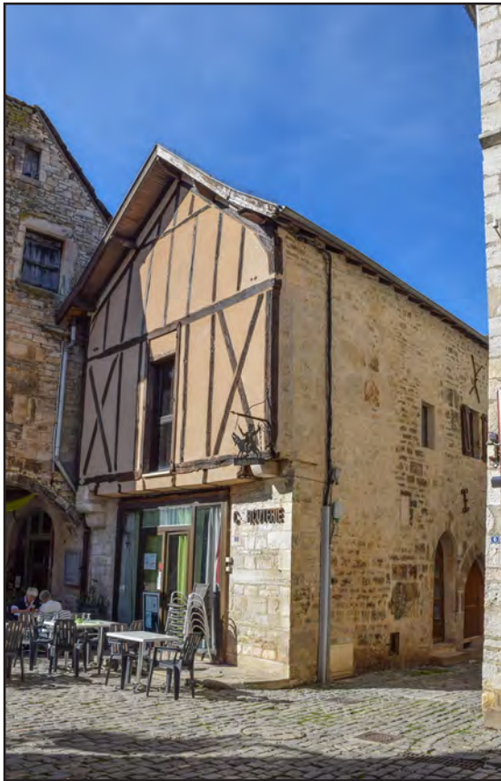
Fig. II-44 : Vue de la maison n° 28, façades sud et est.
