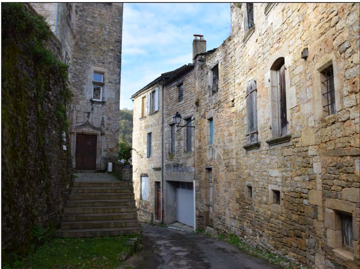
Fig. IV-23 : Vue du pavillon Gauléjac (maison n° 1) depuis le nord-est.
