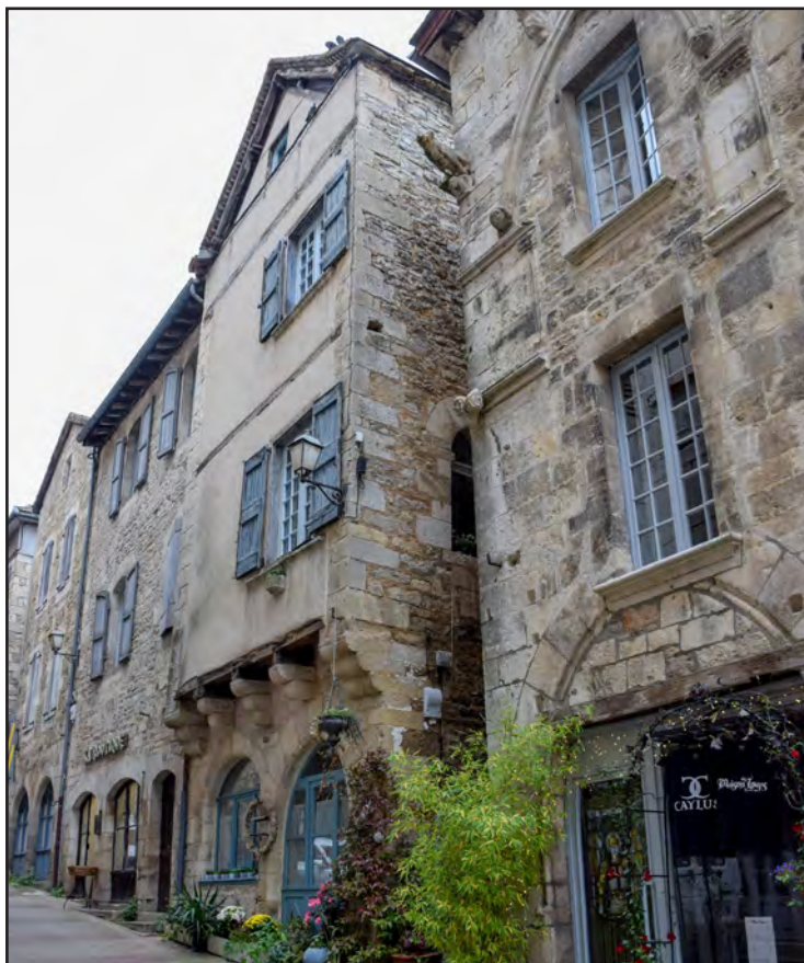
Fig. IV-41 : Vue de la maison n° 14, façades sud et est.
