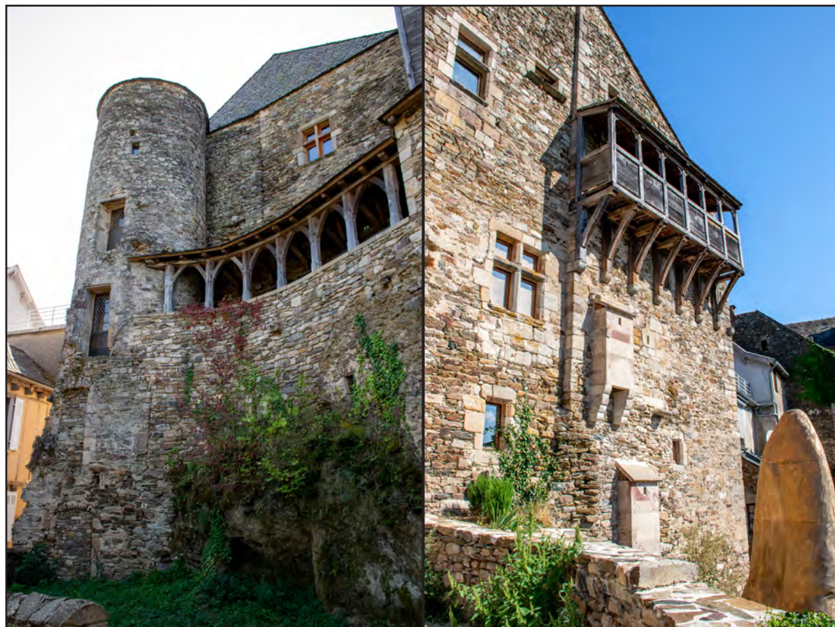
Fig. I-45 : Vue de la maison n° 23 dite « du Gouverneur », façades nord et sud.
