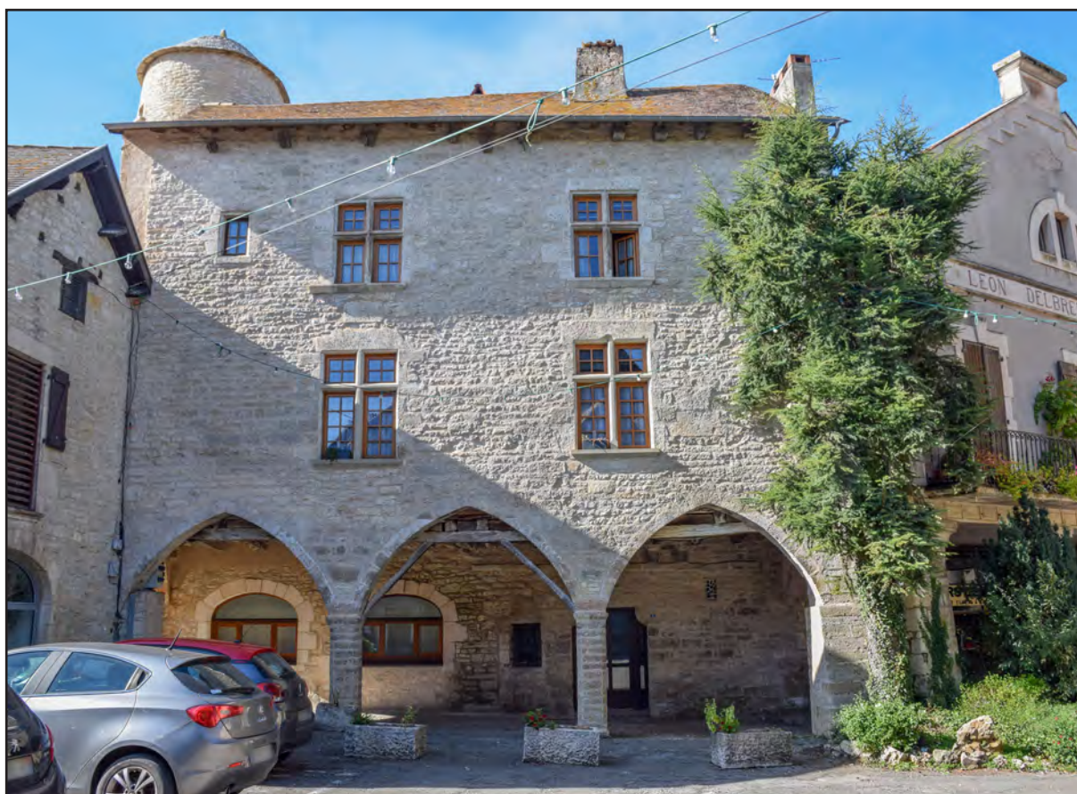
Fig. II-43 : Vue de la maison n° 27, façade est.
