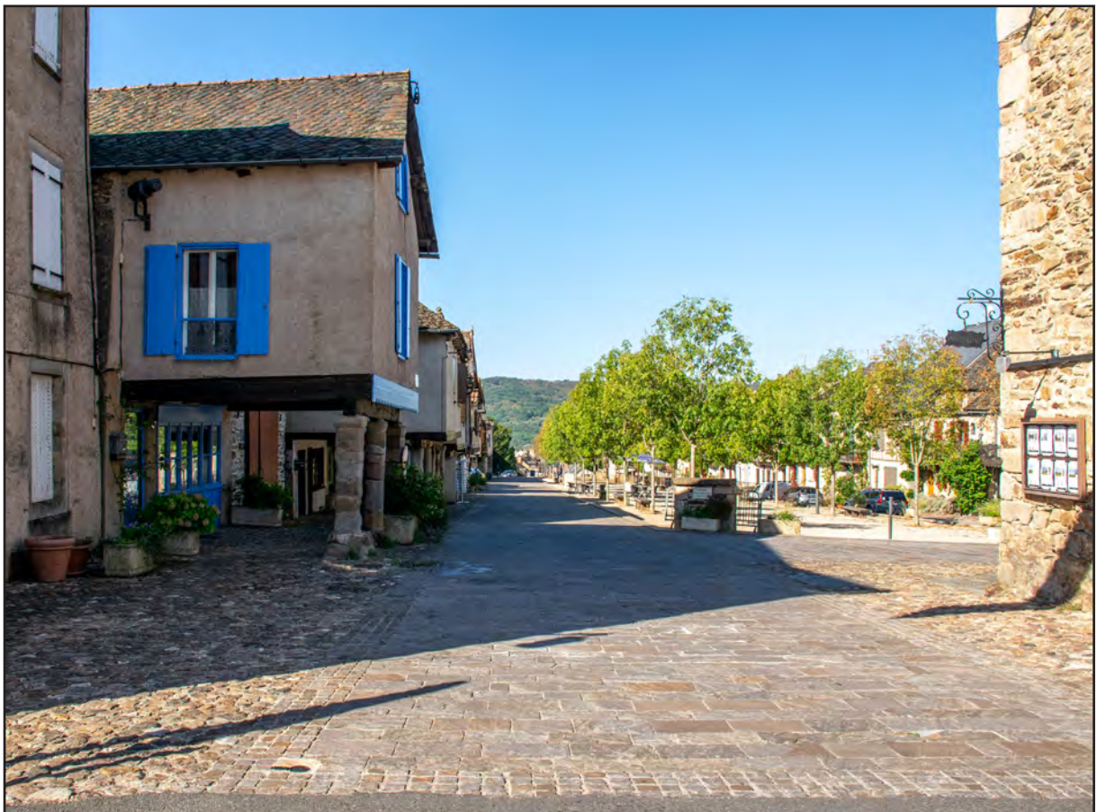
Fig. I-63 : Vue de l'entrée de la place del Gítat (L) depuis l'est.
