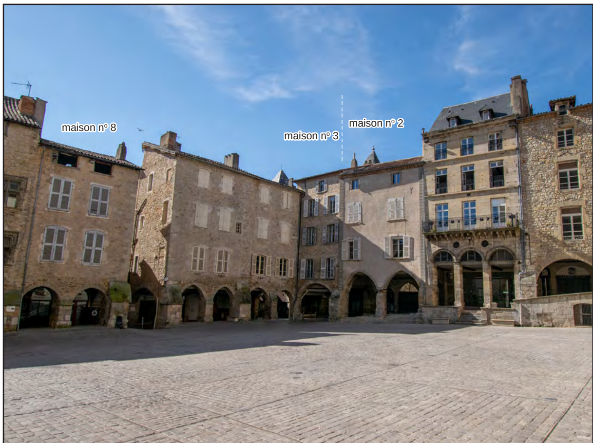
Fig. III-40 : Vue du front sud-ouest de la place Notre-Dame, maisons n° 2, n° 3 et n° 8.
