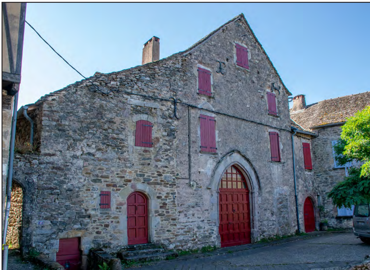
Fig. I-46 : Vue de la maison n° 26, ancien hôpital Saint-Barthélemy, façade nord.
