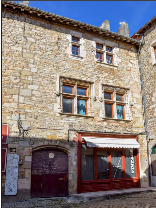
Fig. II-46 : Vue de la maison n° 29, façade sud (2/3).
