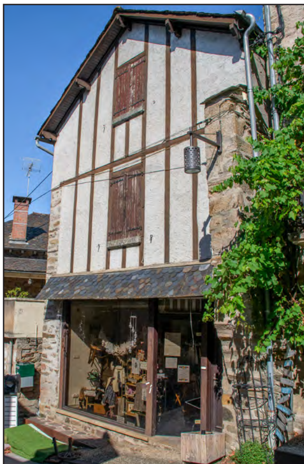
Fig. I-56 : Vue de la maison n° 46, façade sud.
