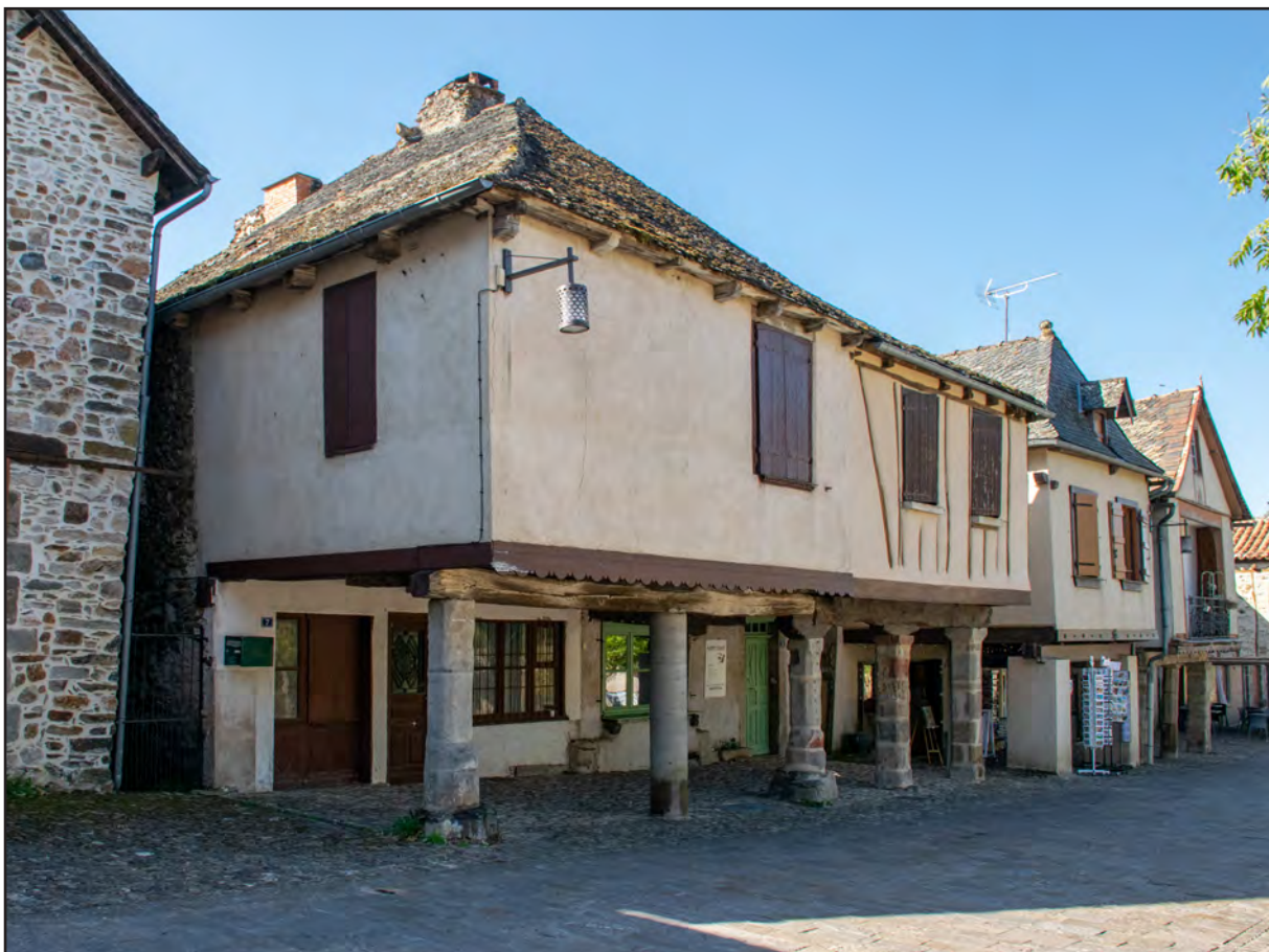
Fig. I-65 : Vue des maisons n° 65-68, façades nord à couverts.
