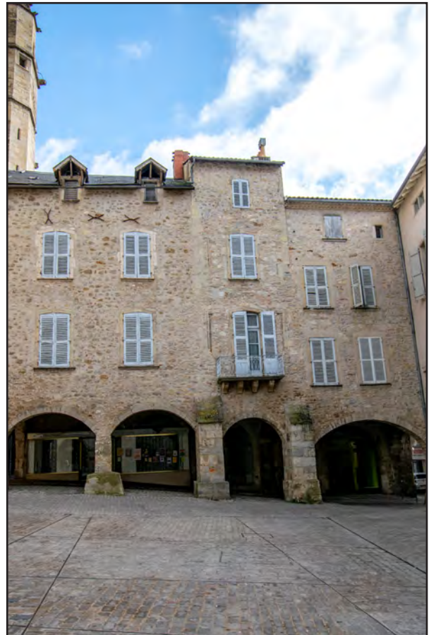
Fig. III-43 : Vue du front est de la place Notre-Dame (maison n° 5).
