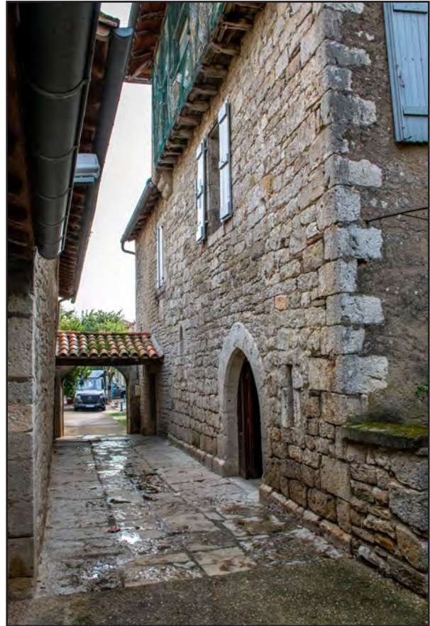
Fig. VI-24 : Vue de la maison n° 2, façade nord.
