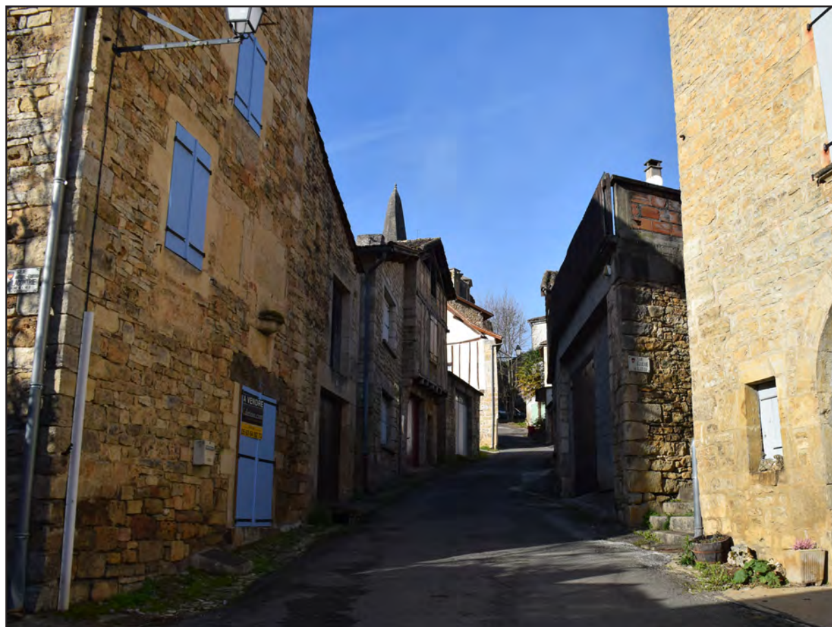
Fig. IV-45 : Vue de la rue du Portanel depuis l'est.
