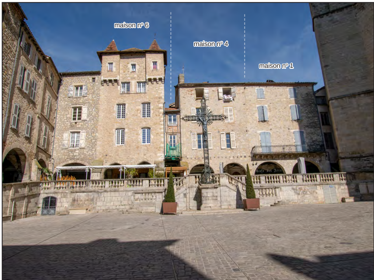
Fig. III-39 : Vue du front nord de la place Notre-Dame, maisons n° 1, n° 4 et n° 6.
