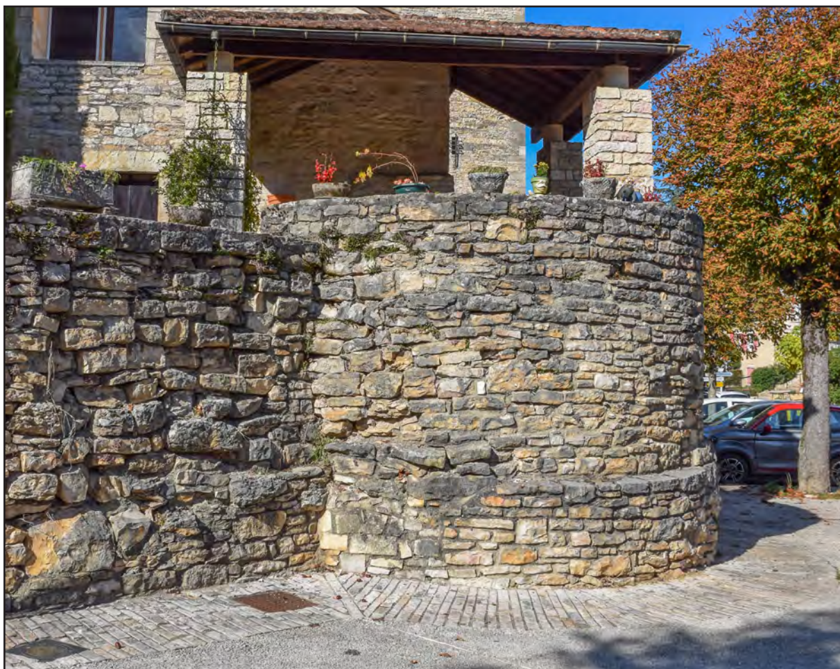
Fig. II-52 : Soubassements de la tour sud-est.
