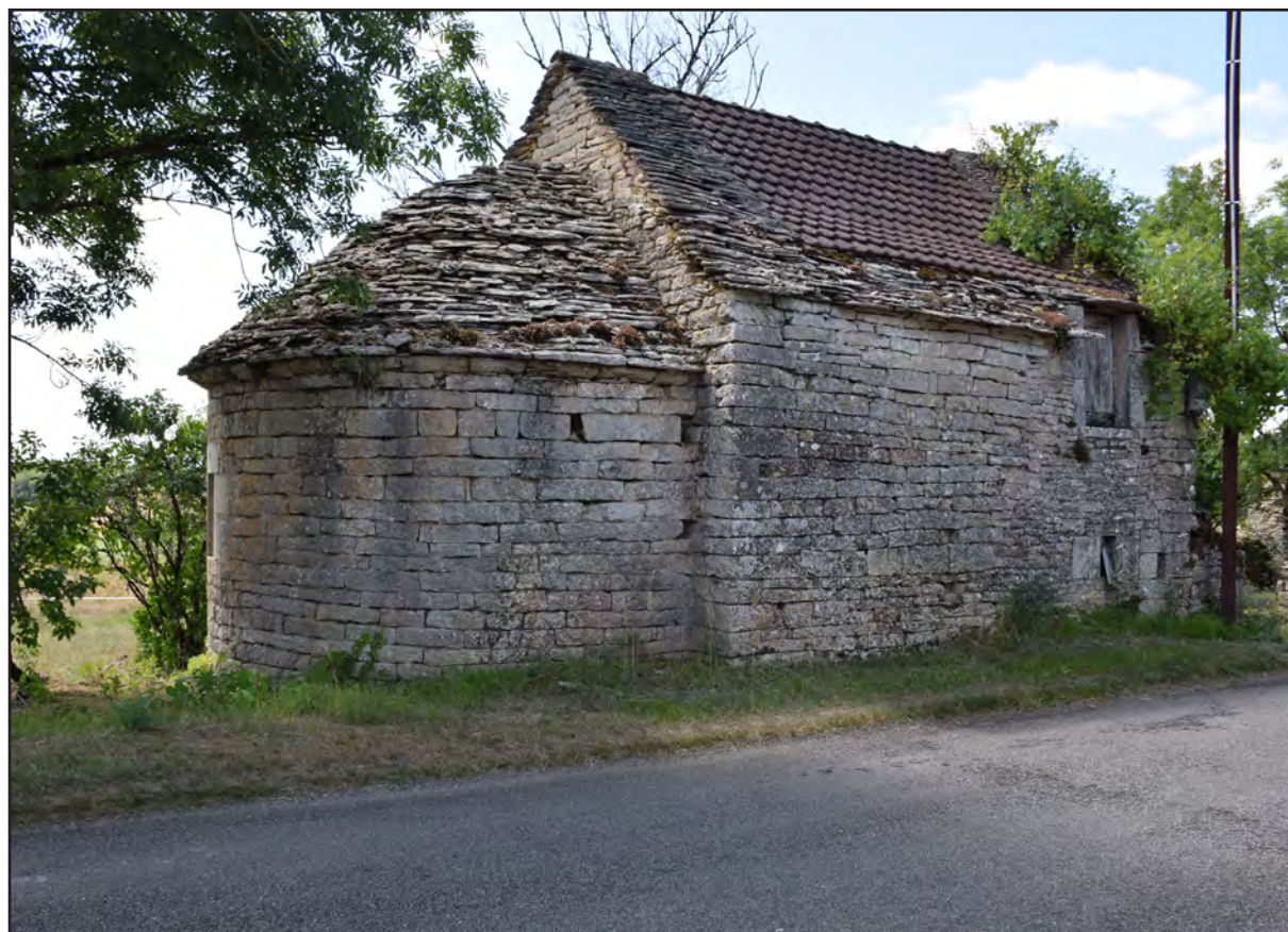
Fig. II-60 : Vue des bâtiments du lieu-dit la Malautie, façades nord et est.
