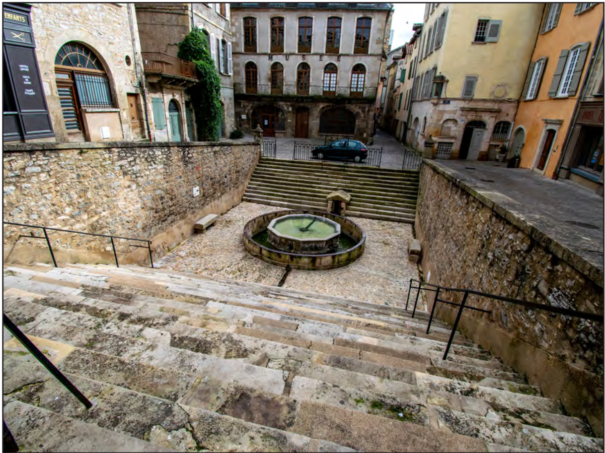
Fig. III-49 : Vue de la fontaine du Griffoul depuis l'ouest.
