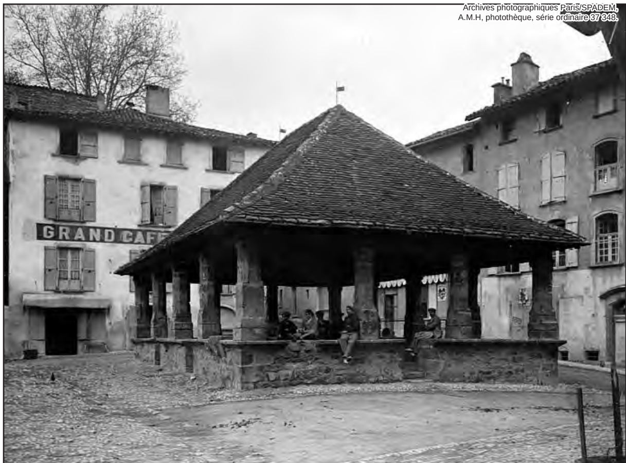
Fig. IV-31 : Vue de la halle de Caylus depuis le sud-ouest avant son déplacement, v. 1900.
