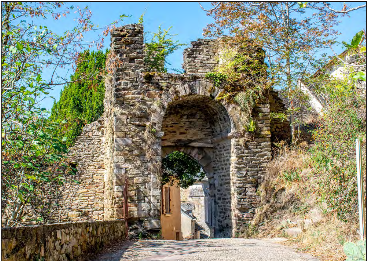
Fig. I-40 : Vue de la porte de la Pique (n° 4), depuis l'est.
