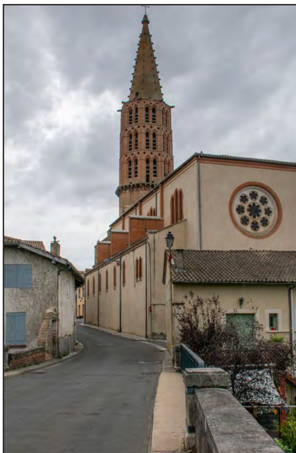
Fig. V-23 : Vue de l'église depuis l'est.
