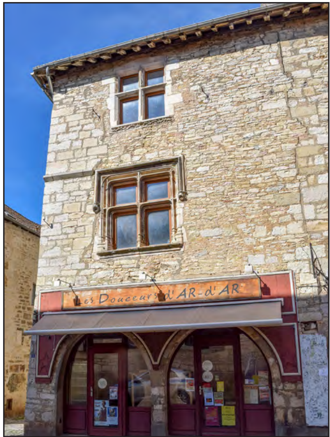
Fig. II-45 : Vue de la maison n° 29, façade sud (1/3).
