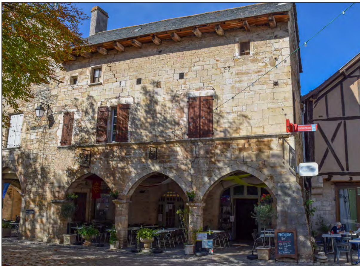
Fig. II-39 : Vue de la maison n° 17, façade sud.
