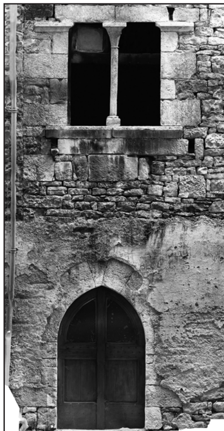
Fig. IV-42 : Orthophotographie partielle, maison n° 15, façade est.
