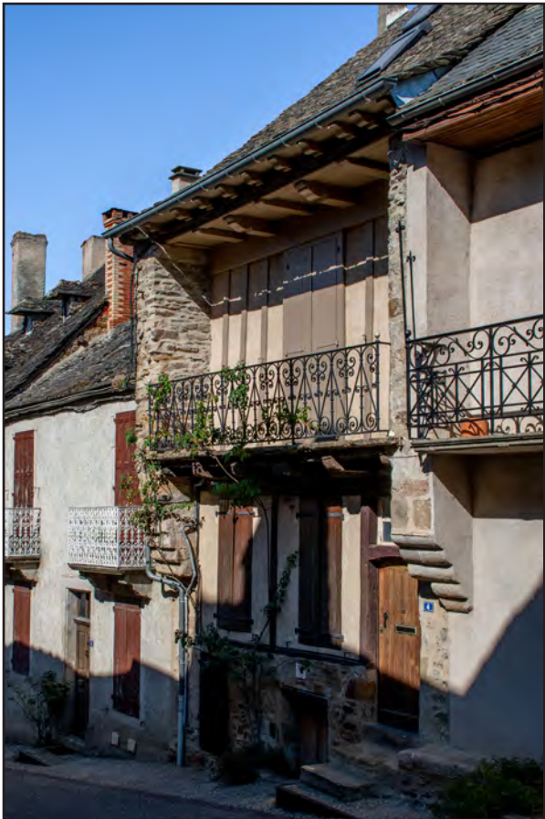
Fig. I-58 : Vue de la maison n° 51, façade sud.
