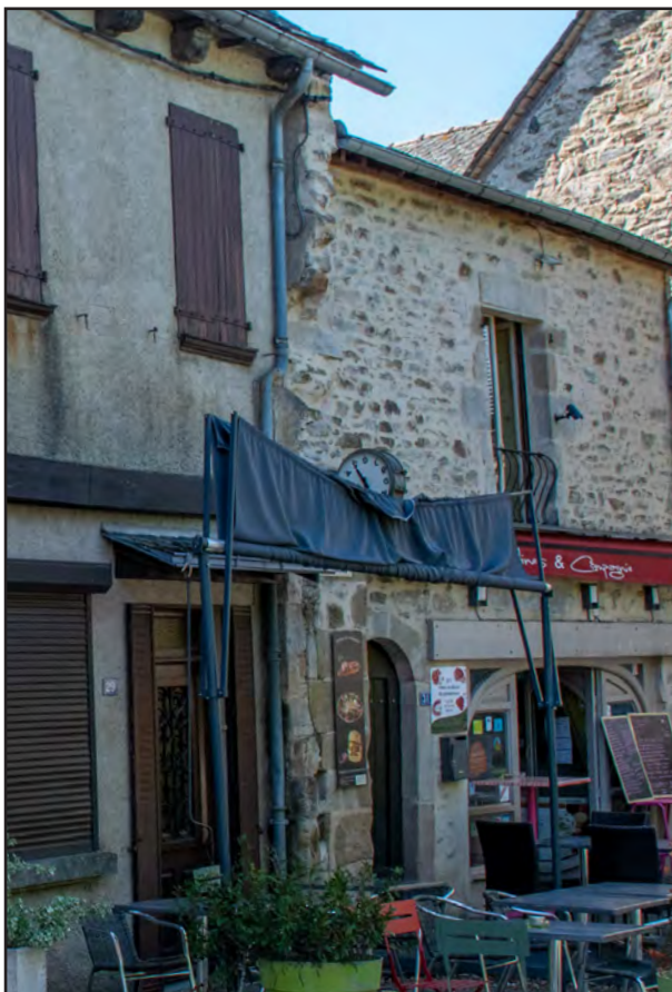
Fig. I-47 : Traces d'arrachement, chaînage avec le portail de Missandre (n° 10).
