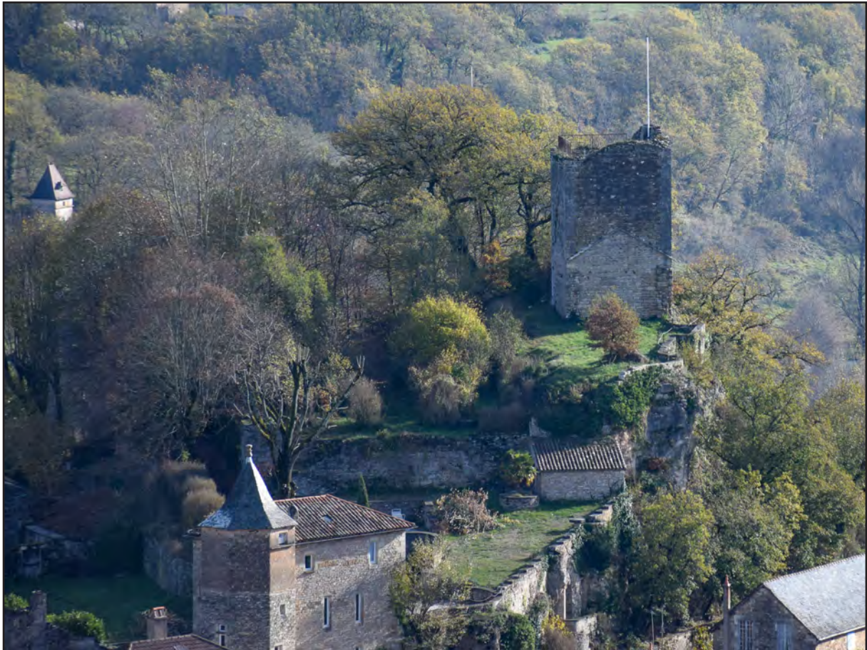
Fig. IV-22 : Vue du pavillon Gauléjac (maison n° 1) et de la tour castrale depuis l'ouest.
