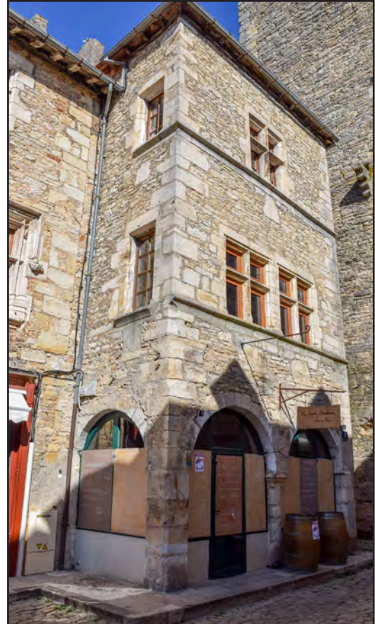
Fig. II-47 : Vue de la maison n° 29, façade sud (3/3).
