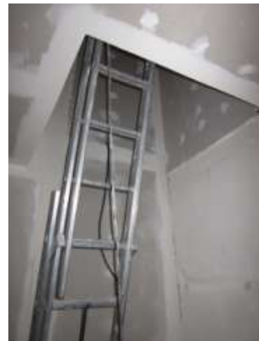
Ouverture futur escalier pour étage
