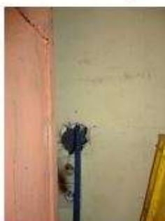
Installation électrique dangereuse : fils dénudés, câble libre, prises brûlées.
