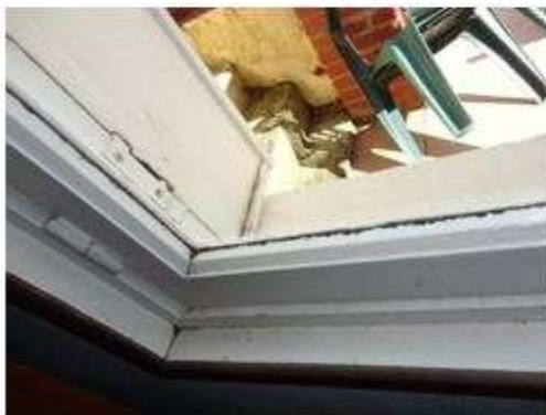
Détail de la menuiserie bois à remplacer
