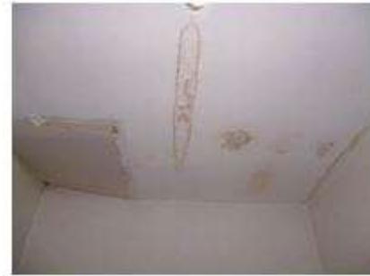
Traces d'infiltration
