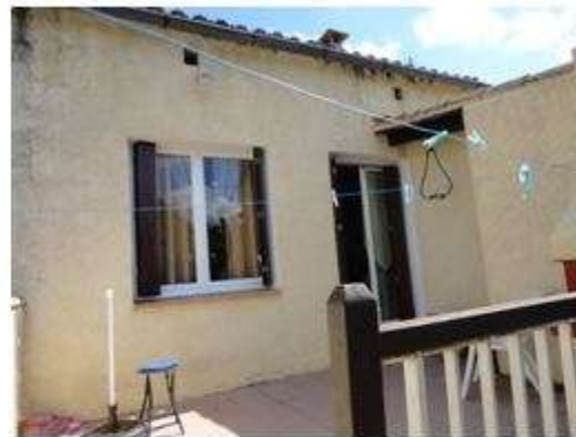
De la façade arrière
