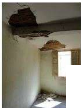
Infiltrations d'eaux de pluie visibles en plafond
