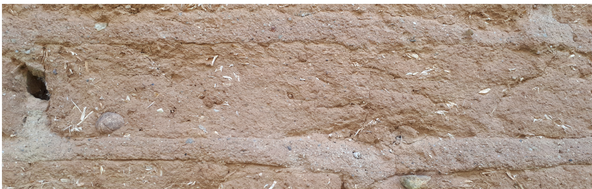
Déail d'appareillage en adobes du patrimoine fibrés.
