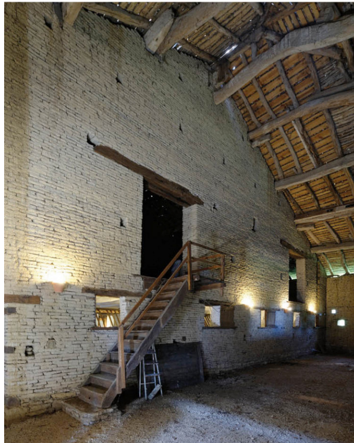
Ci-dessus : appareillage en damier de l'Astarac-Magnoac (Gers) et mur en adobes d'une grange de Réalville (Tarn et Garonne)
