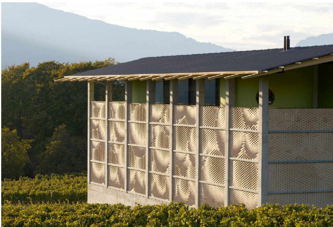
Ci-dessous : Mur rideau en briques cuites reproduisant le motif d'une grappe de raisin pour un chai du domaine viticole de Gantelbein (Suisse), réalisé à l'aide d'un robot.
