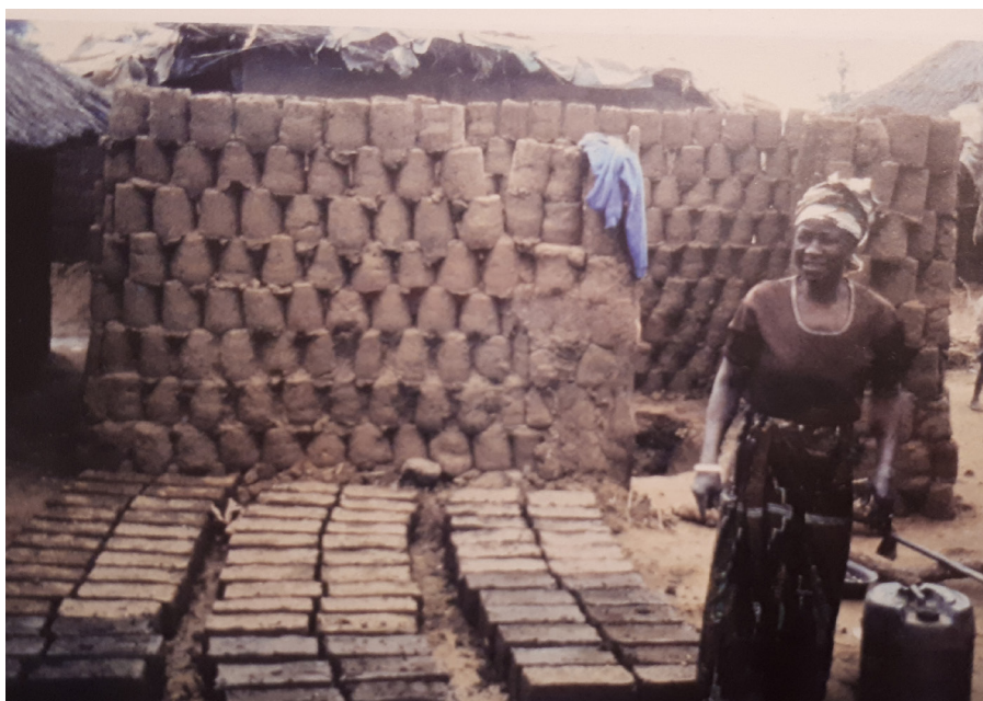
Evolution de la brique crue modelée vers la brique crue moulée, Zambie, 1997. Photo : archive CRATerre
