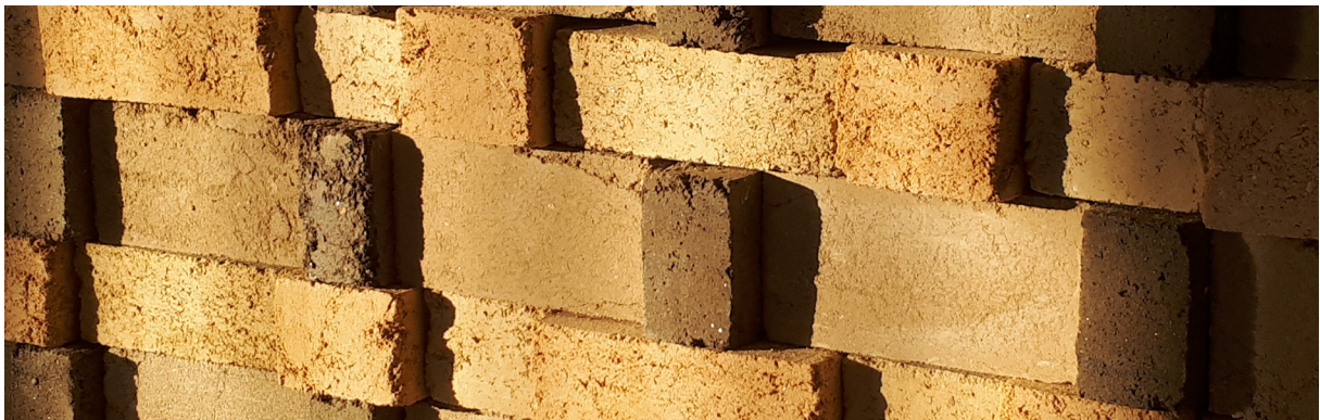
Appareillage expérimental en briques de terre crue réalisé dans le cadre du master
