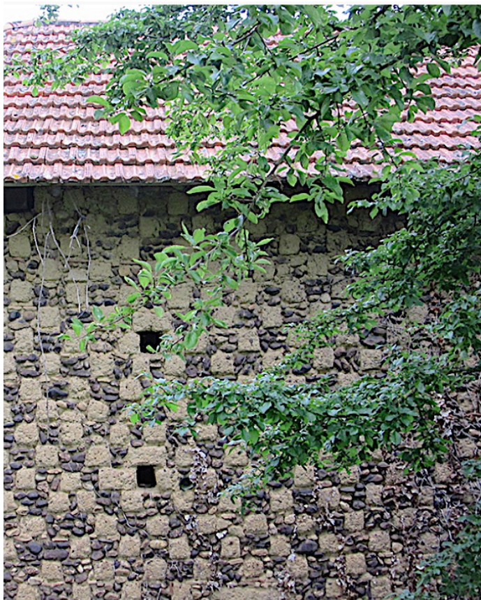
Ci-dessus : appareillage en damier de l'Astarac-Magnoac (Gers) et mur en adobes d'une grange de Réalville (Tarn et Garonne)
