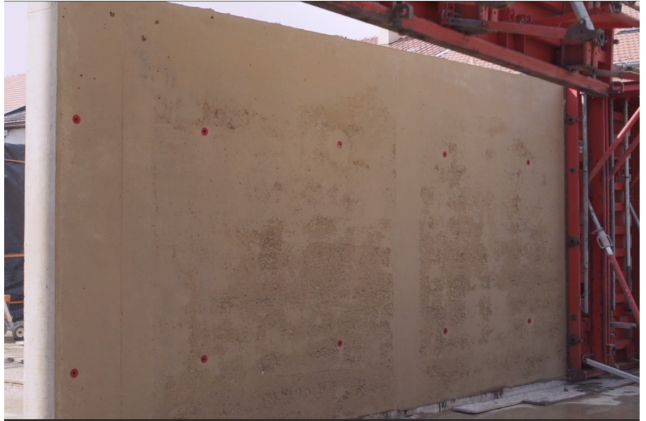
Béton de terre coulée : décoffrage du mur. images issue du film Construire en terre crue – Terre coulée, Licence Creative Commons amàco et Les films du lierre.
