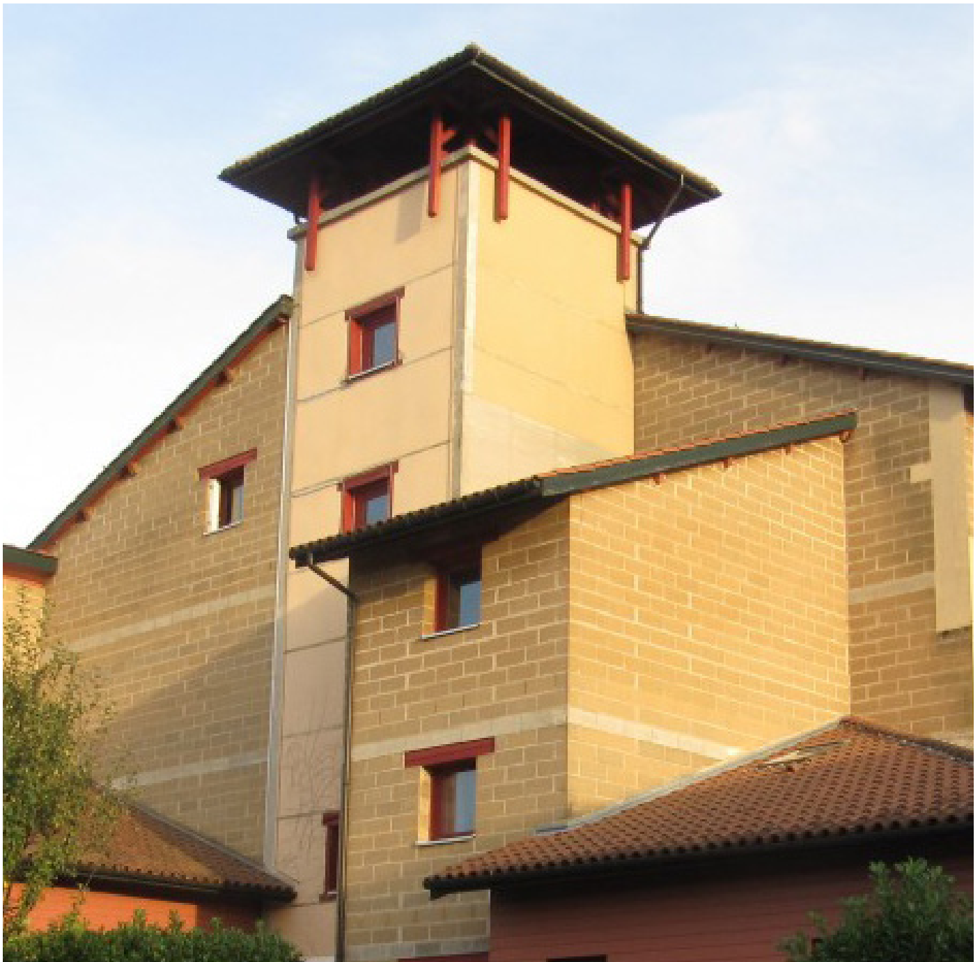
Ci-dessus : Domaine de la terre, Villefontaine, L'Isle d'Abeau, bâtiment construit en BTC adjuvantées en ciment. 1982
