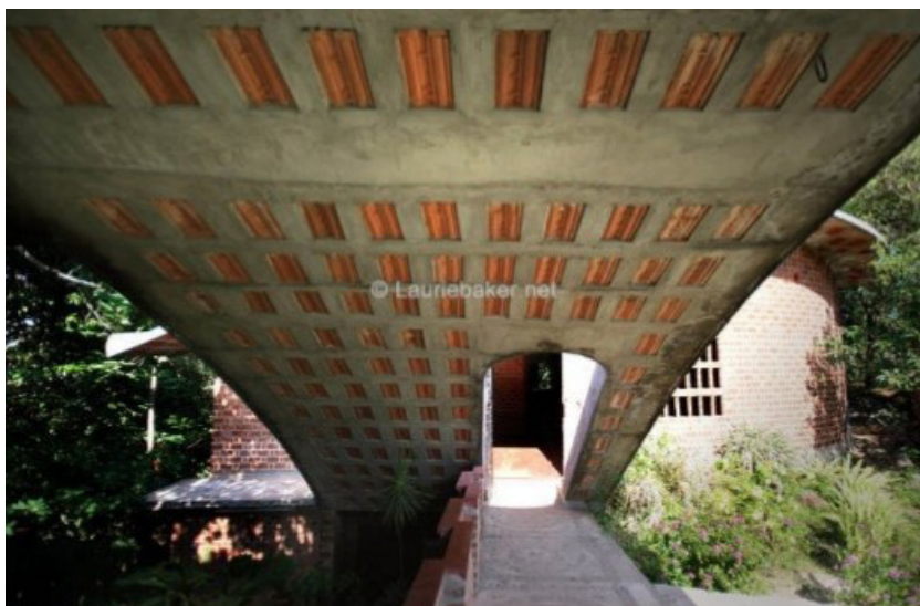
Ci-dessous: Centre for Development Studies, 1973, Trivandrum, détails d'éléments constructifs voûte en "Filler stab" et escalier.
