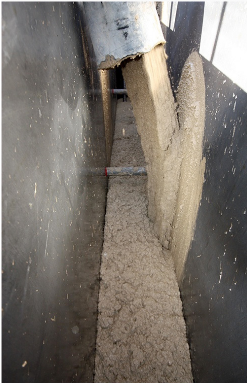
Béton de terre coulée : remplissage des coffrages. Crédit photographique : Mathieu Neuville
