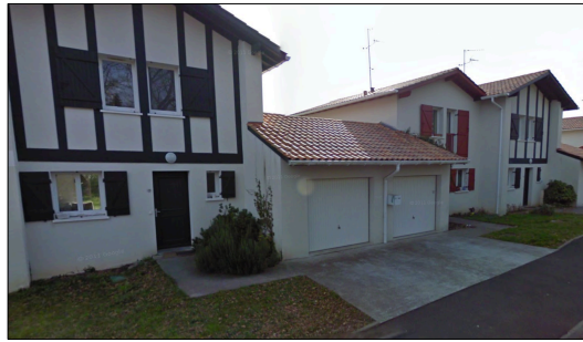
FIGURE 13 : CREATION D'HABITAT PAVILLIONNAIRE - EXEMPLE A BAYONNE (64)
