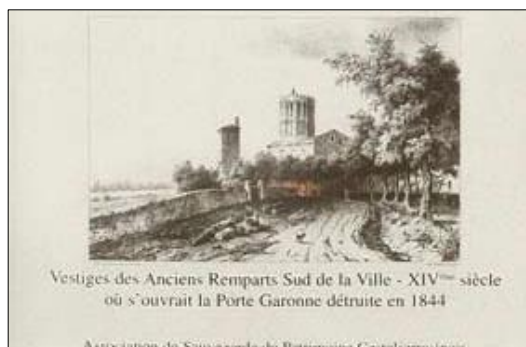
FIGURE 6 : VESTIGES DES REMPARTS SUD
