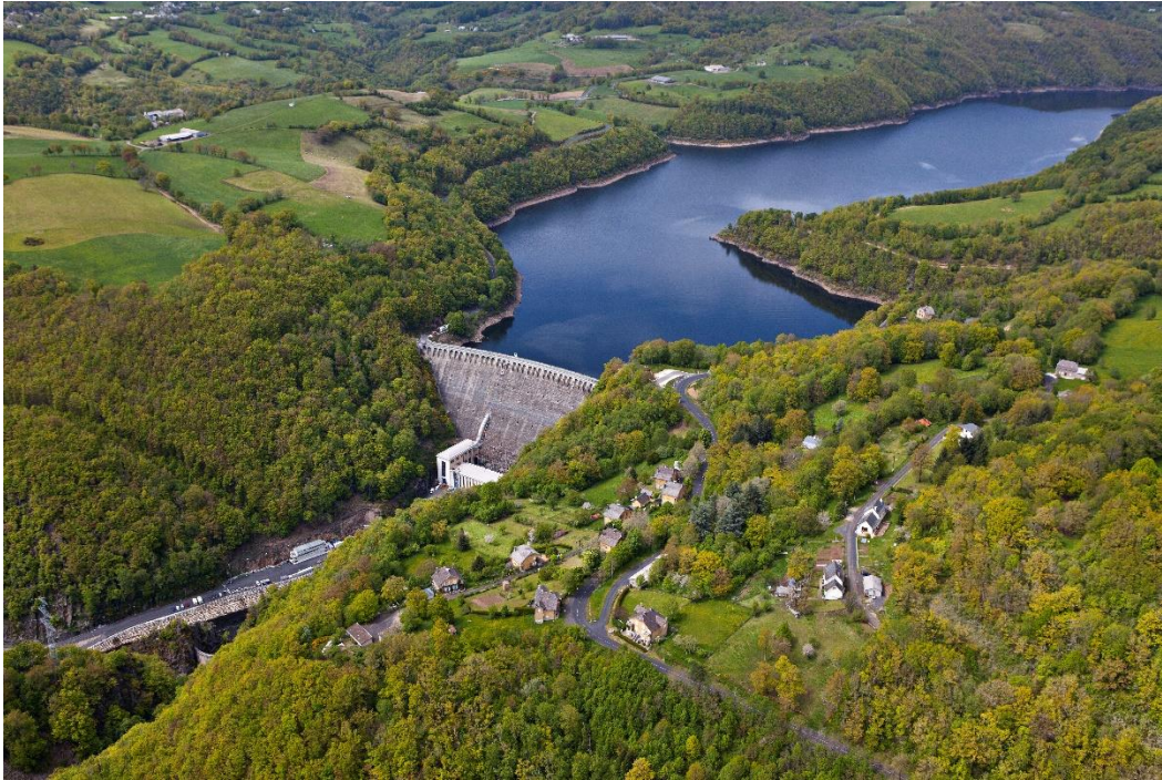
Figure 22 : Vue aérienne du barrage de Sarrans
