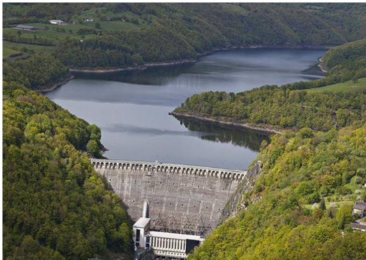
Figure 24 : Le barrage hydroélectrique de Sarrans
