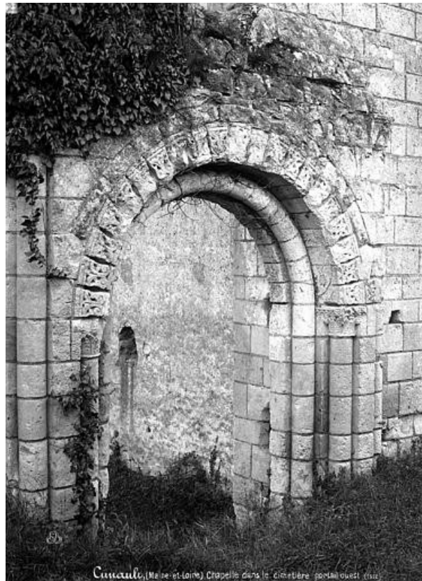
[Figure. 79] Portail occidental de l'église Saint-Maxenceul de Cunault, Photographie de 1892 « Cunault, Maine-et-Loire, Chapelle dans le cimetière », MH7960, Médiathèque du patrimoine et de la photographie, J/84/49/1017-2.
