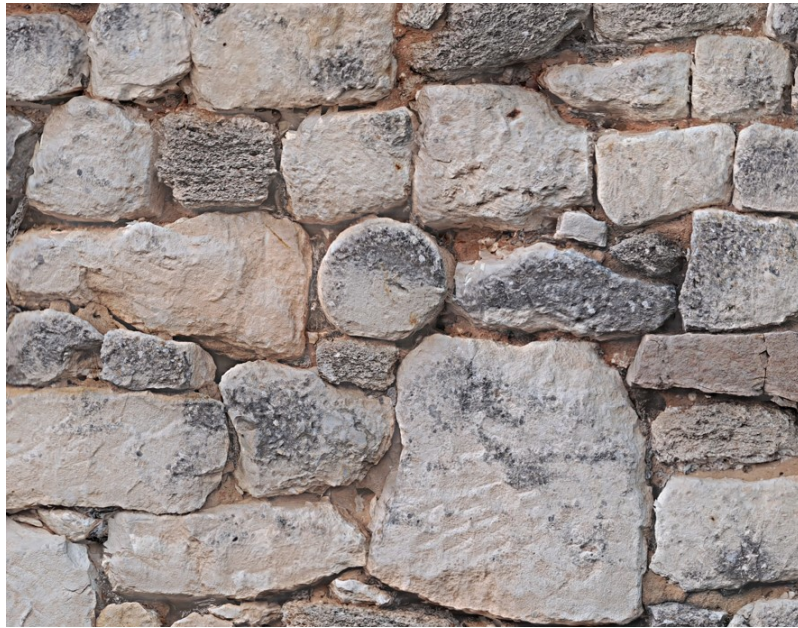
[Figure. 18] Détail d'un moellon circulaire de la section ouest de la face extérieure du mur méridional de l'église Saint-Maxenceul à Cunault.
