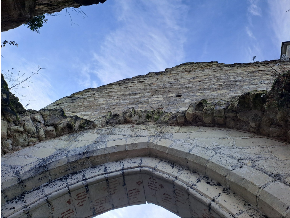
[Figure. 43] Vue du pignon oriental depuis l'intérieur du chœur de l'église Saint-Maxenceul à Cunault.
