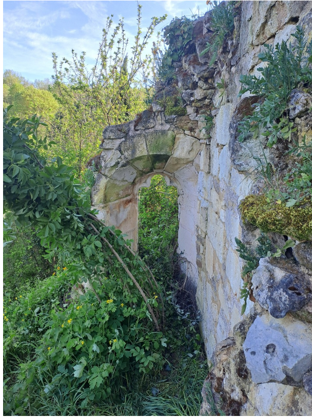
[Figure. 45] Fenêtre est du mur méridional du chœur des ruines de l'église Saint-Maxenceul à Cunault.
