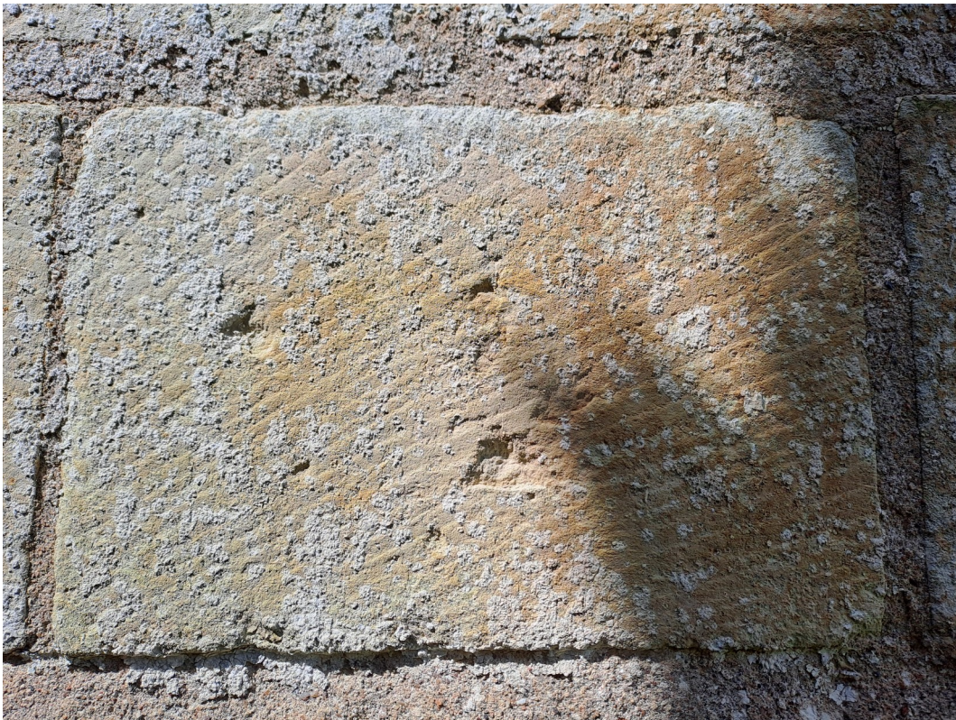
[Figure. 78] Layage caractéristique de l'usage du marteau taillant sur un bloc du revers de la façade de l'église Saint-Maxenceul à Cunault.
