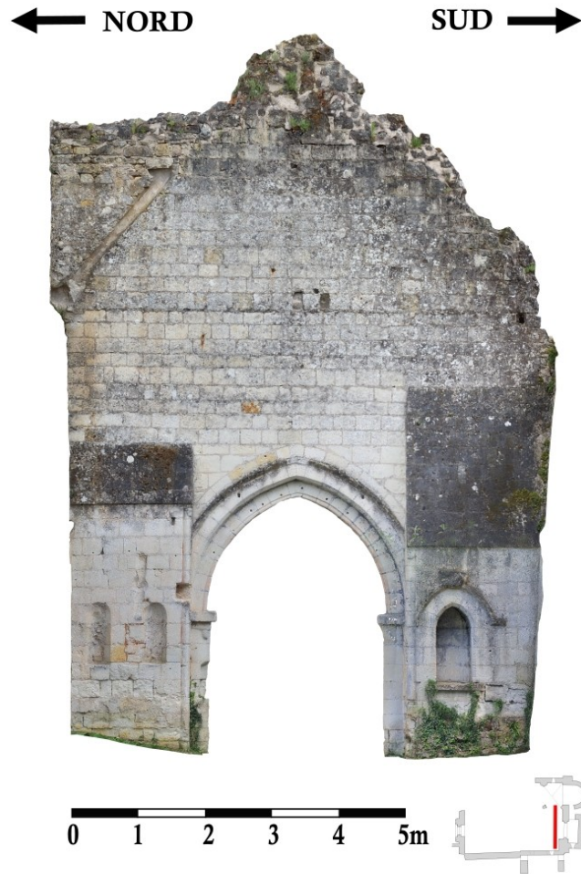
[Figure. 29] Orthophotographie de la face intérieure du pignon oriental de l'église Saint-Maxenceul à Cunault.
