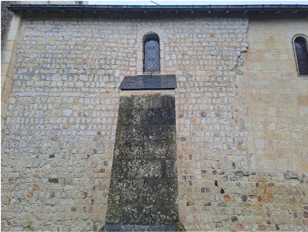
[Figure. 72] Mur gouttereau sud de la nef de l'église Saint-Sulpice à Rou, Maine-et-Loire.
