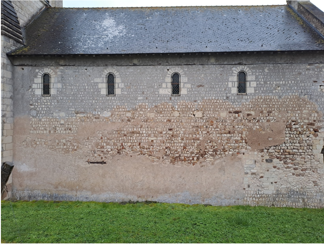
[Figure. 71] Mur gouttereau nord de la nef de l'église Saint-Julien à Distré, Maine-et-Loire.
