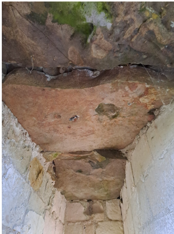
[Figure. 64] Couverture de l'espace entre le chœur et l'absidiole des ruines de l'église Saint-Maxenceul à Cunault.
