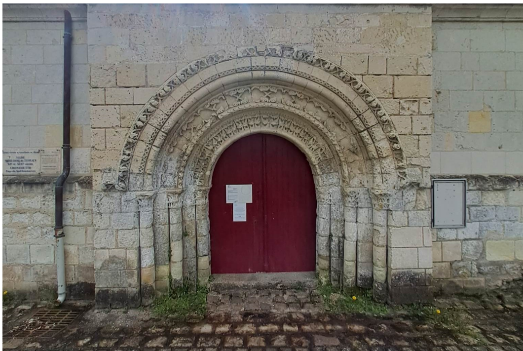
[Figure. 82] Portail nord de l'église Notre-Dame-des-Tuffeaux à Chênehutte, Maine-et-Loire.
