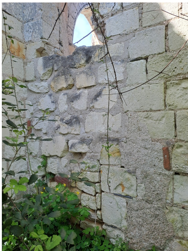
[Figure. 47] Détail de la maçonnerie du mur méridional du chœur des ruines de l'église Saint-Maxenceul à Cunault.
