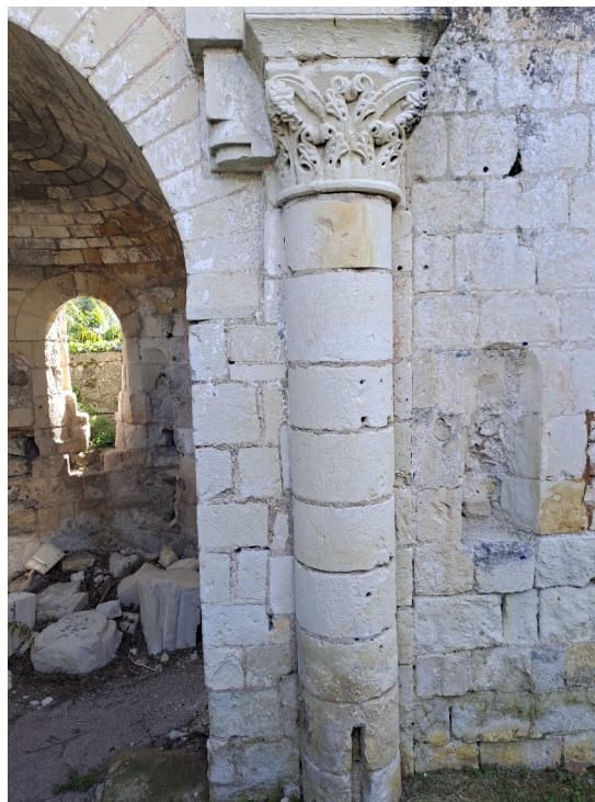
[Figure. 58] Colonne engagée entre le pignon oriental et l'absidiole des ruines de l'église Saint-Maxenceul à Cunault.
