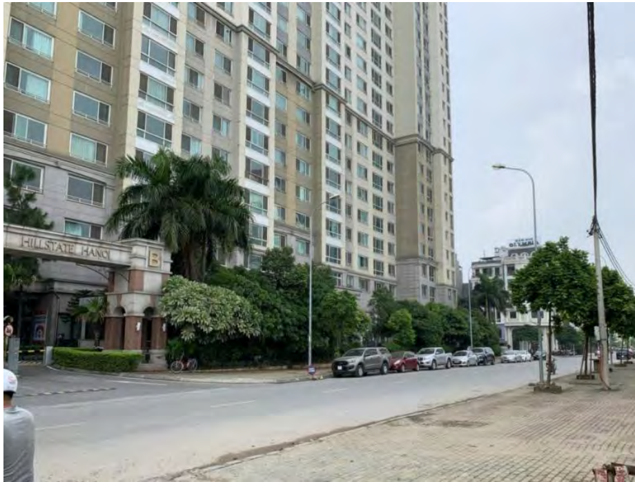
Figure 73. Le portail B de CCTM Hyundai Hillstate
