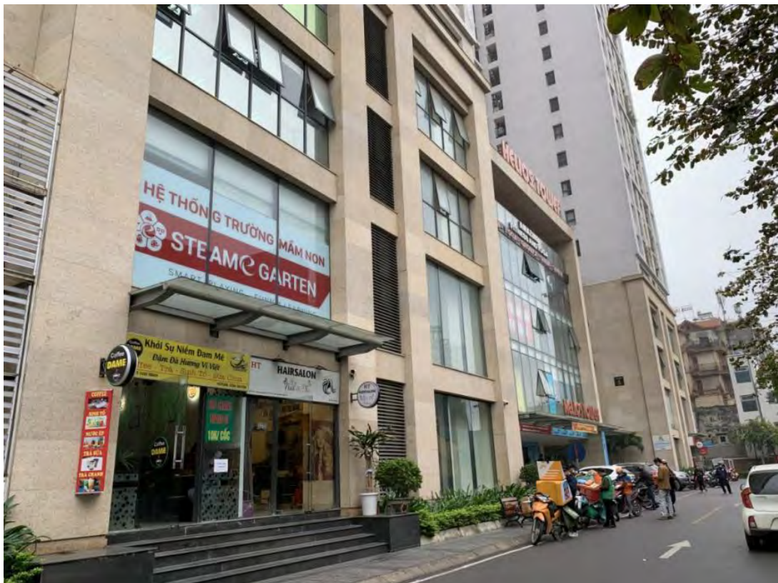
Figure 83. Socle de commerce, bureaux, l'école maternelle et la salle de sport - Helios Tower
