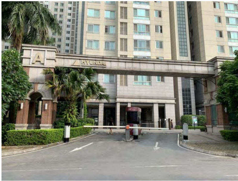
Figure 71. Le portail A de CCTM Hyundai Hillstate
