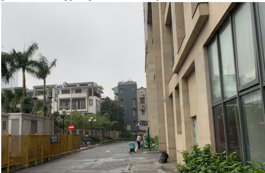
Figure 88. L'espace réservé aux activités des résidents apparaît très limité au pied de l'immeuble – Helios Tower
