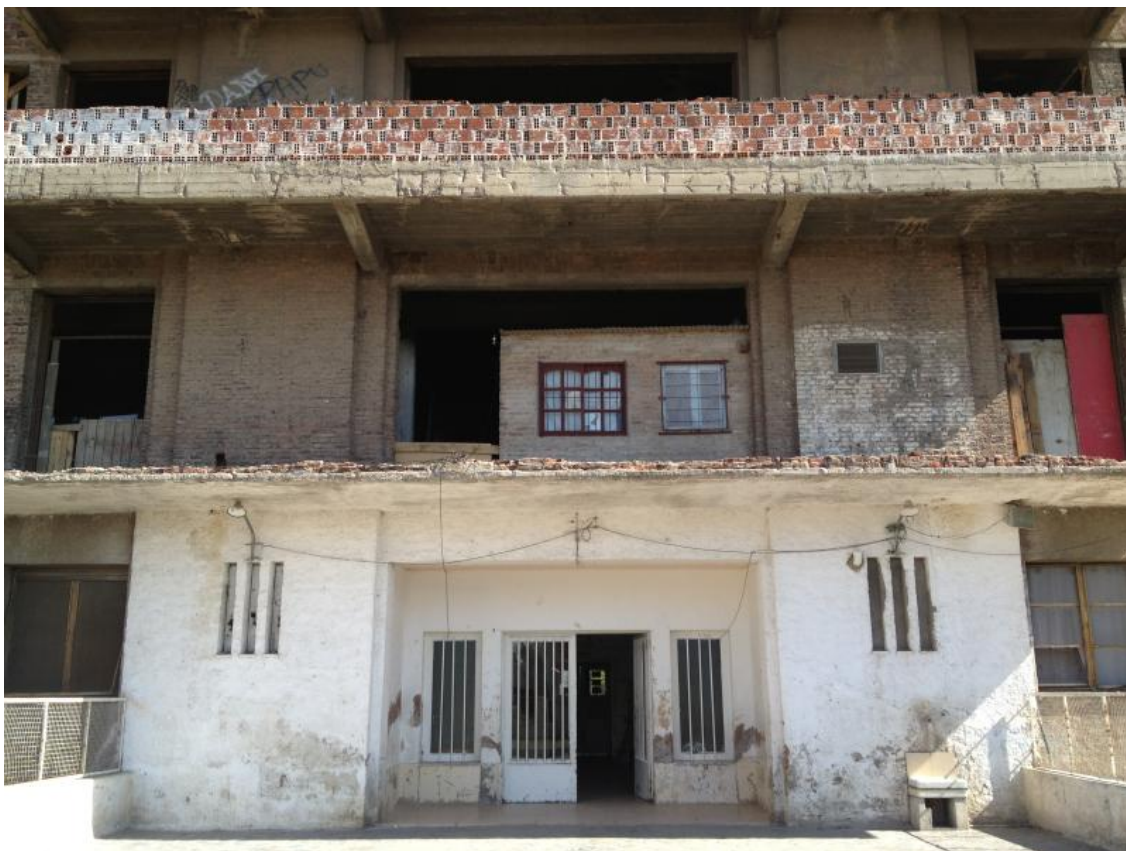
Figure 6-26 - Photographie de la façade arrière de El Elefante Blanco montrant, au premier étage, la présence d'une maison construite sur le plateau libre de la GSA. Source : auteur, 2014
