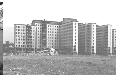
Structure : El Albergue Warnes Début du chantier : 1951 Crédit : Archivo di film Argentina, 1991
