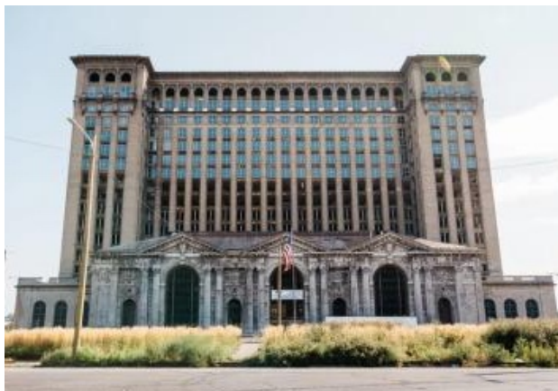
Figure 6-22 - Photographie de la façade avant de l'ancienne gare de Détroit, connue sous le nom de Michigan Central Station (Spécimen #025), montrant la pose de fenêtres sur les six étages supérieurs de la structure. Source : Michelle et Chris Gerard, 2015
