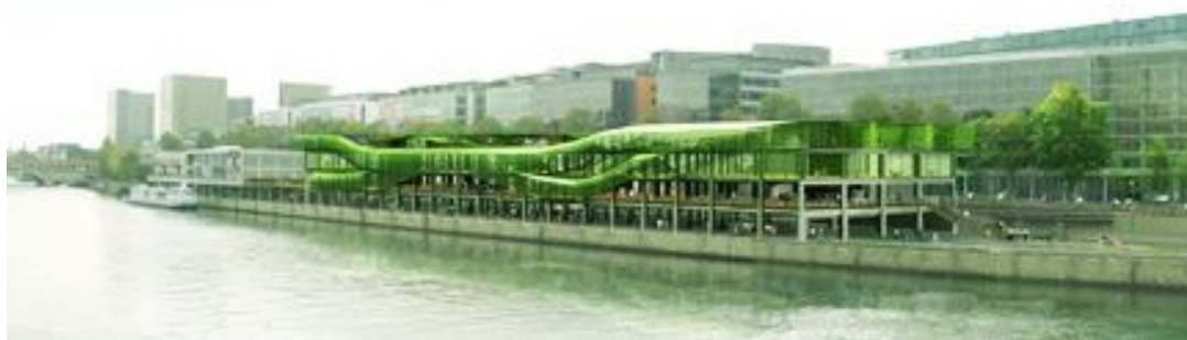
Figure 6-13 - Rendu 3D des Docks 'Cité de la Mode et du Design' montrant la greffe se déployant, côté Seine, sur l'ossature industrielle des anciens Magasins Généraux d'Austerlitz. Source : Jakob & MacFarlane, 2004
