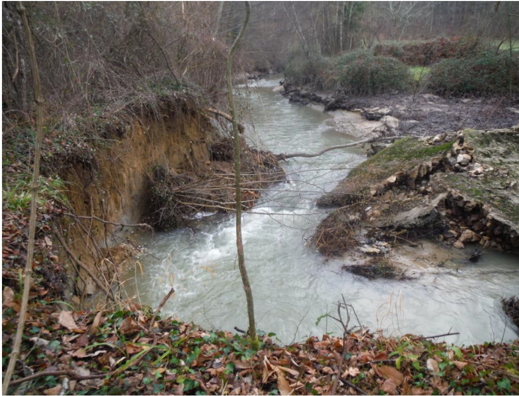
Illustration 25: Illustration du contournement total et de l'érosion en rive droite après la crue le 16 Janvier 2018. ©SYCOSERP - 16/01/2018
