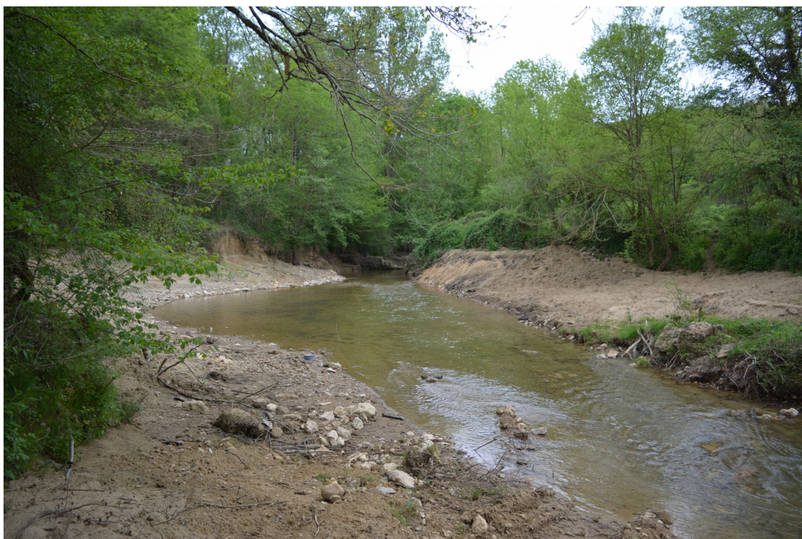
Illustration 29: Faciès du lit mineur du cours d'eau après effacement du seuil et comblement de la berge. Le cours d'eau ne va plus "racler" la berge à gauche de l'image. Le lieu fait aujourd'hui l'objet d'une surveillance pour observer l'évolution. ©Alexandre Tournié - 27/04/2018
