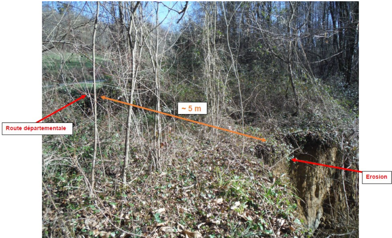
Illustration 26: L'érosion de la berge a réduit la distance entre le cours d'eau et la route de 10 mètres en 4 semaines. Avant le début des travaux, la distance n'était plus que de 5 mètres entre le lit mineur et la route départementale. ©SYCOSERP
