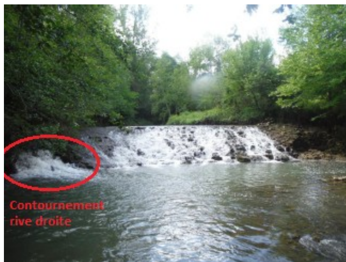
Illustration 24: Le seuil en 2014, la brèche a gauche de l'image commençait à créer un début de contournement du seuil par le cours d'eau (entouré en rouge). ©Géodiag - SYCOSERP
