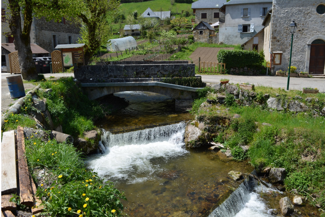
Illustration 20: Le seuil est constitué de deux petits seuils consécutifs. Le pont est possiblement stabilisé par ce seuil. On constate la pente forte du lit mineur. ©Alexandre Tournié - 24/04/2018
