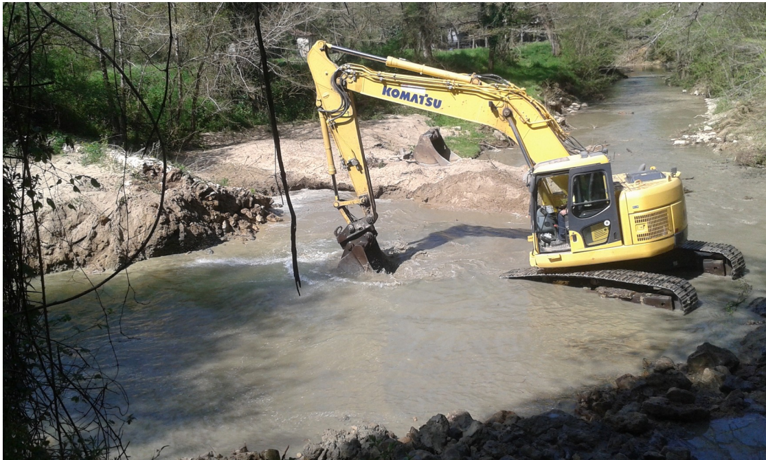
Illustration 27: Travaux d'effacement du seuil au mois d'Avril. ©Alexandre Tournié - 19/04/2018
