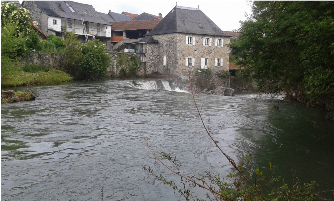
Illustration 18: Seuil de Moulis vu depuis l'amont. L'image fournit un aperçu de l'urbanisation sur les rives et permet d'apprécier la hauteur de chute au niveau du seuil. ©Alexandre Tournié - 15/05/2018
