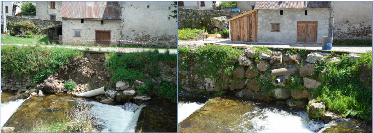
Illustration 12: Réparation d'un désordre observé en 2014 (photo de gauche) sur le seuil de la Rivière d'Alos, sur la commune d'Alos. ©Alexandre Tournié – 24/04/2018
