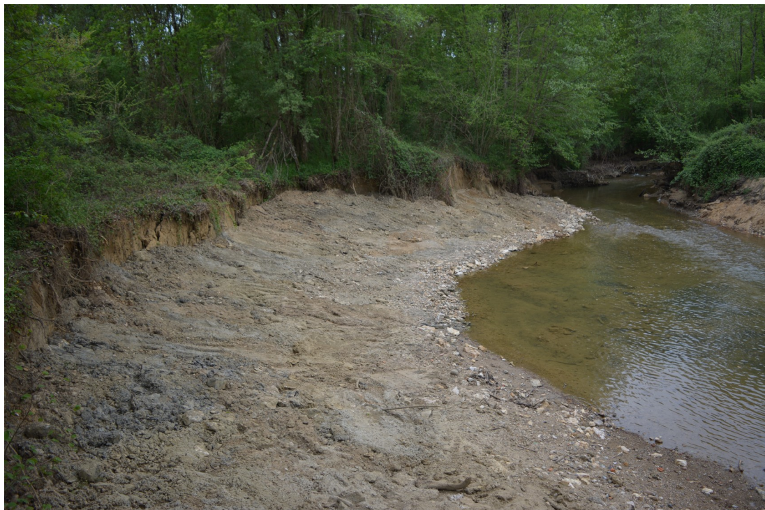
Illustration 28: Comblement de la berge en rive droite pour rétablir le tracé originel dur lit mineur et empêcher la poursuite de l'érosion latérale. ©Alexandre Tournié - 27/04/2018
