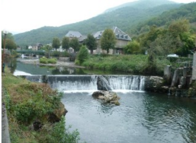
Illustration 6: Seuil des anciens ateliers Charrons à Engomer.
