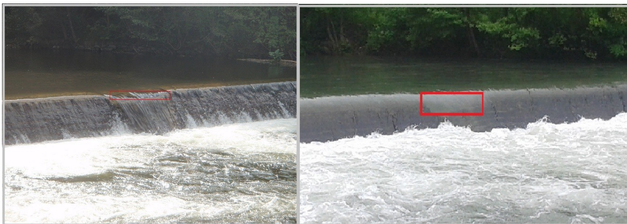
Illustration 22: Illustration de l'évolution de la brèche (encadrée en rouge) sur la crête de l'ouvrage situé sur la commune de Lacourt. A gauche la photo datant de 2015, montrant une brèche de petite taille sur le haut de la crête de l'ouvrage. A droite, la photo de 2018 démontrant l'incision très nette de la brèche qui démantèle le corps du seuil et le creuse inexorablement. ©Alexandre Tournié - 31/05/2018
