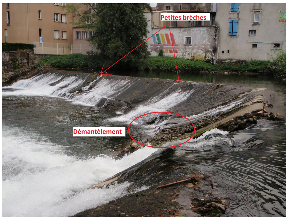
Illustration 15: Seuil de Balagué depuis la rive gauche. Cette photo prise en 2014 met en évidence les petites brèches sur la crête et le démantèlement du corps de l'ouvrage. ©SYCOSERP
