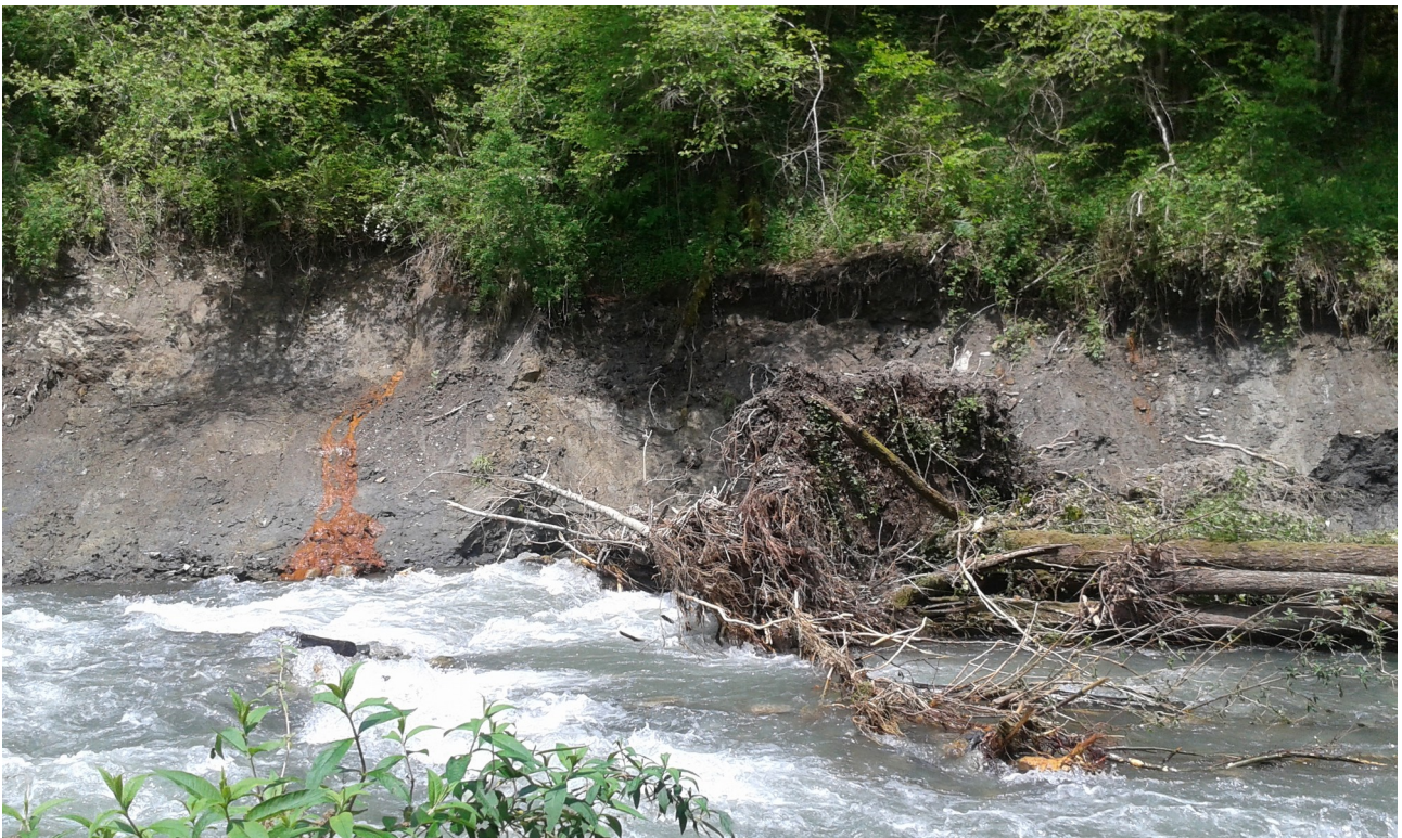
Illustration 32: Zoom sur l'effondrement de berge, conséquence de l'érosion importante qui a fait suite à l'augmentation du débit de la rivière. Cette photo a été prise depuis le banc de matériaux qui a été déposé en rive convexe. ©Alexandre Tournié - 16/05/2018
