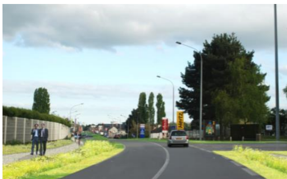
Figure 10 : Après végétalisation des trottoirs
