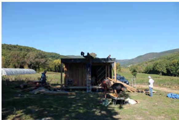
Photo 102 : Acheminement de la terre sur le toit.
