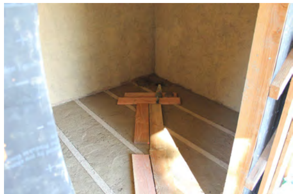
Photo 103 : Dalle de terre crue.
