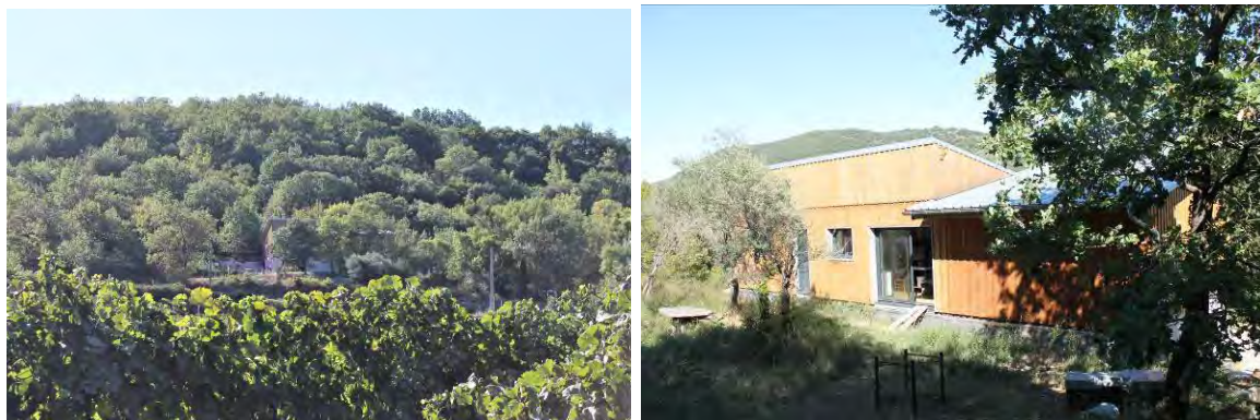
Photo 37 : Miellerie (Hérault). Vue d'ensemble. Les deux toits monopentes rappellent les mazets traditionnels. Le bâtiment s'intègre dans le couvert végétal : le bardage bois est de teinte miel, les ouvertures et les menuiseries sont de teinte gris anthracite (O.R., 2022).
