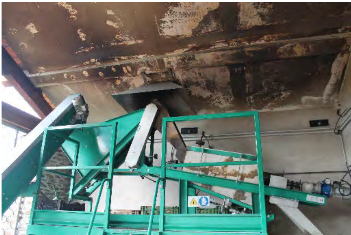
Photo 54 : Décortiqueuse de châtaignes (ATC de végétaux) (O.R., 2022). Un pare-feu métallique a été installé après la réalisation du bâtiment, pour protéger la charpente (en bois) des flammes.
