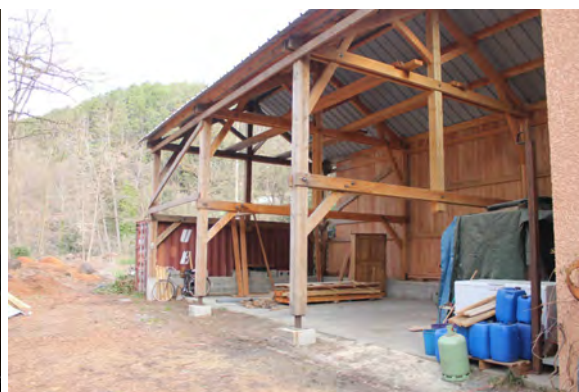
Photo 95 : Hangar de stockage et conteneur.
