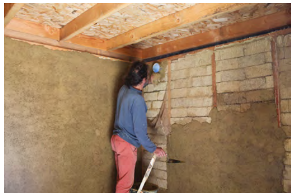
Photo 101 : Pose de l'aération.
