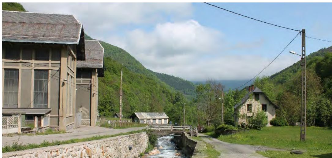
Photo 35 : Ancien logement EDF réaménagé (870 m. d'alt.), au bord du Lez. Vue d'ensemble. Le bâti a été reconverti en petit pool d'activités, dont une miellerie au sous-sol. La toiture en ardoises dispose d'une pente d'environ 40 %. Elle est équipée d'arrêts de neige métalliques car les épisodes neigeux sont fréquents en hiver (O.R., 2022).
