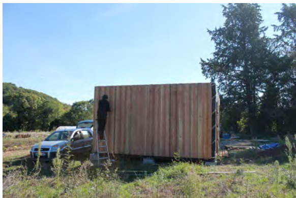
Photo 100 : Fixation du bardage bois.
