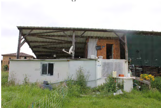
Photo 80 : Fromagerie et bureau au R+1.
