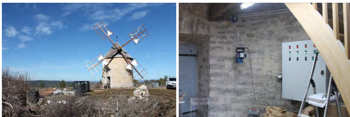
Photo 40 : Moulin de la Borie (Lozère). Vue d'ensemble et tableau de bord électrique (O.R., 2022).
