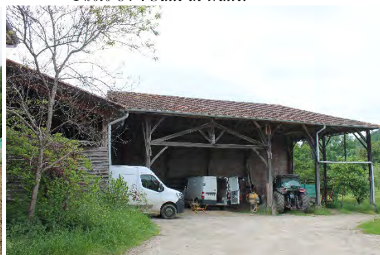
Photo 83 : Hangar de stockage.
