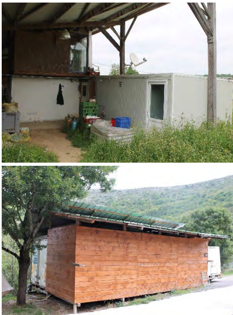
Photo 27 : Fromageries en préfabriqués (Ariège) et en caissons frigorifiques (Gard) (O.R., 2022).
