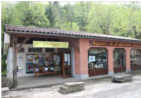
Photo 59 : Boutique de producteurs aménagée dans un ancien lavoir, en centre-ville (Castelnau-Durban, Ariège) (O.R., 2022). La propriété du bâti est communale. Créée en 1993, la boutique comptait 54 producteurs en 2021. D'une surface de 70 m 2 , le bâtiment en béton banché n'est pas prévu pour fonctionner en hiver (simple vitrage, absence d'isolation). La boutique est ouverte 1/2 journée par semaine en hiver, et tous les jours durant la saison estivale.
