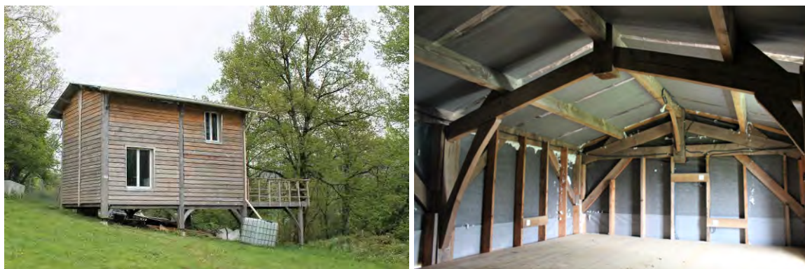
Photo 11 : Bâtiment de stockage et de conditionnement de végétaux en bois, réalisé en autoconstruction partielle, en 2018 (Ariège) (O.R., 2022).
