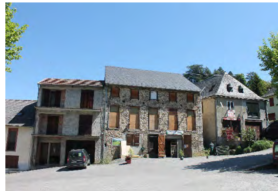
Photo 60 : Boutique de producteurs (propriété intercommunale) aménagée au rez-de-chaussée d'une vieille bâtisse de village, en 2021 (Castillon-en-Couserans, Ariège) (O.R., 2022). Sa rénovation a été réalisée via un chantier participatif. Les murs ont été refaits à la chaux. D'une surface de 40m 2 , la boutique comptait une quarantaine de producteurs en 2022.
