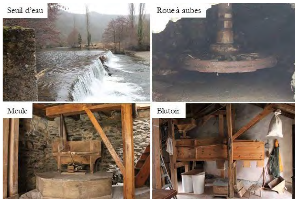
Photo 43 : Moulin de Grattevals. Seuil d'eau et équipements (O.R., 2022).
