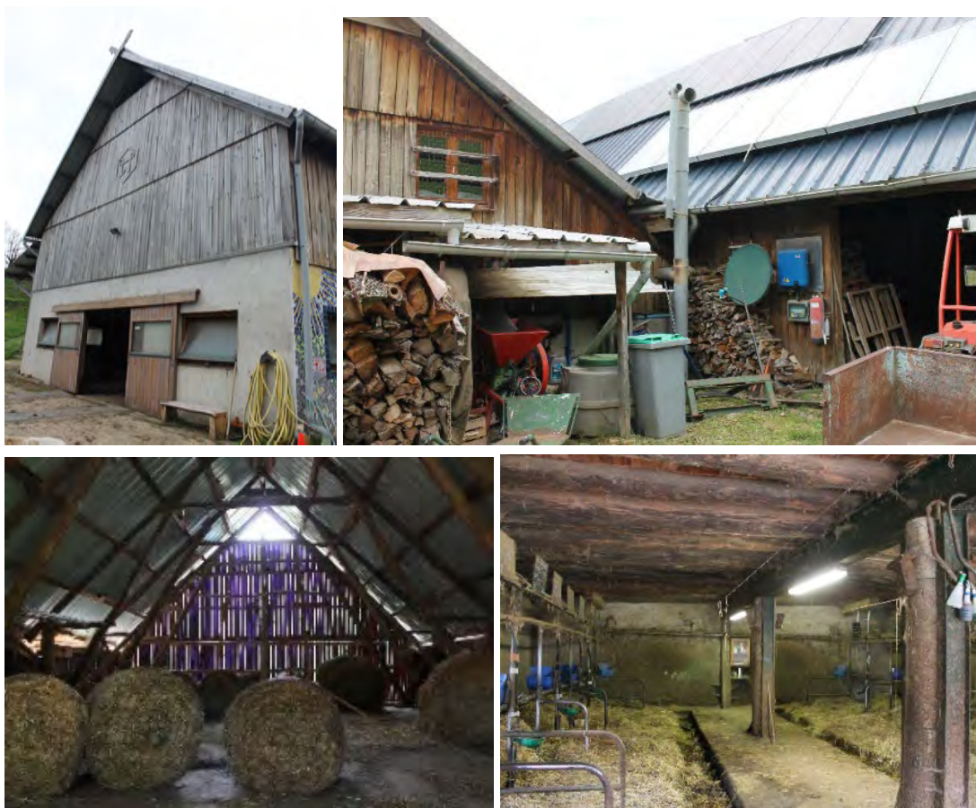
Photo 16 : Stabulation entravée autoconstruite en 2005 (300 m 2 ) à partir de bois local (chêne, châtaigner, frêne), selon le modèle des fermes alpines traditionnelles, avec étable en parpaings au niveau 0, et stockage du fourrage en bardage bois au niveau 1 (Ariège) (O.R., 2022). Le bâtiment est orienté est-ouest pour installer des panneaux solaires sur la toiture en bac acier. Il est intégré dans la pente, ce qui permet un accès de plain-pied à l'espace de stockage du foin situé à l'étage. Le bardage bois à l'étage procure une ventilation naturellement de la pièce. Un système de trappe permet de transférer le foin directement dans l'étable située juste en dessous. La traite est réalisée dans l'étable (double tuyau). Une petite porcherie est construite au nord du bâtiment, mais n'est plus utilisée.
