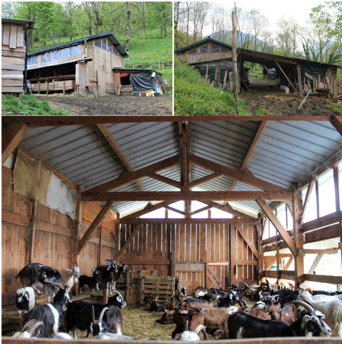
Photo 88 : Bâtiment d'élevage (O.R., 2022). Chèvrerie et espace de stockage conçu dans le prolongement de la chèvrerie.
