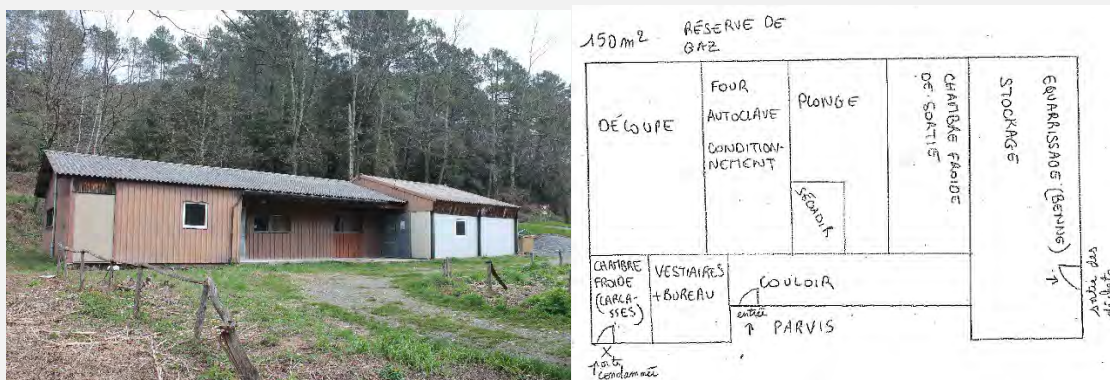
Photo 50 : Atelier de transformation collectif des Hauts-Gardons. Vue extérieure et plan (O.R., 2022)
