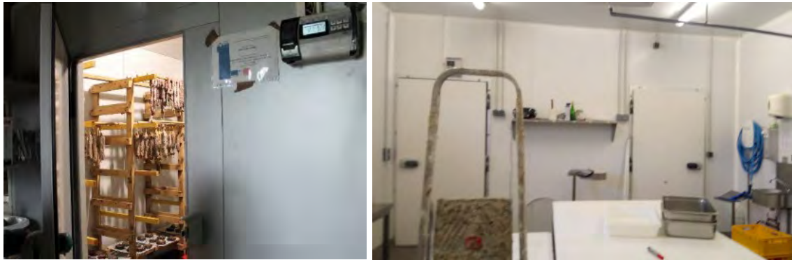
Photo 30 : Aménagement intérieur d'ateliers de transformation carnée, en panneaux sandwichs. Photographie 1 : séchoir (Ariège), photographie 2 : salle de découpe (Hérault) (O.R., 2022).
