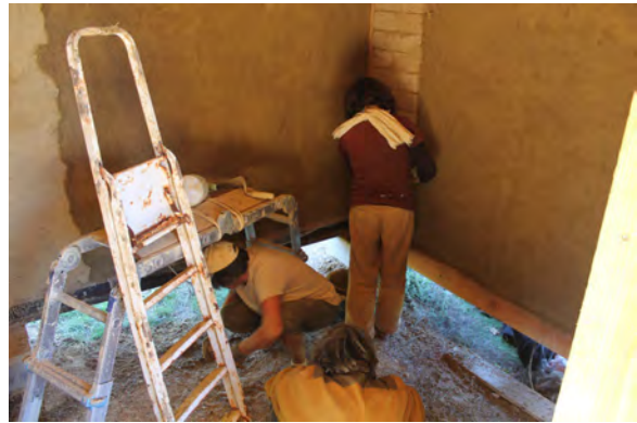
Photo 99 : Enduit des murs de la chambre froide.
