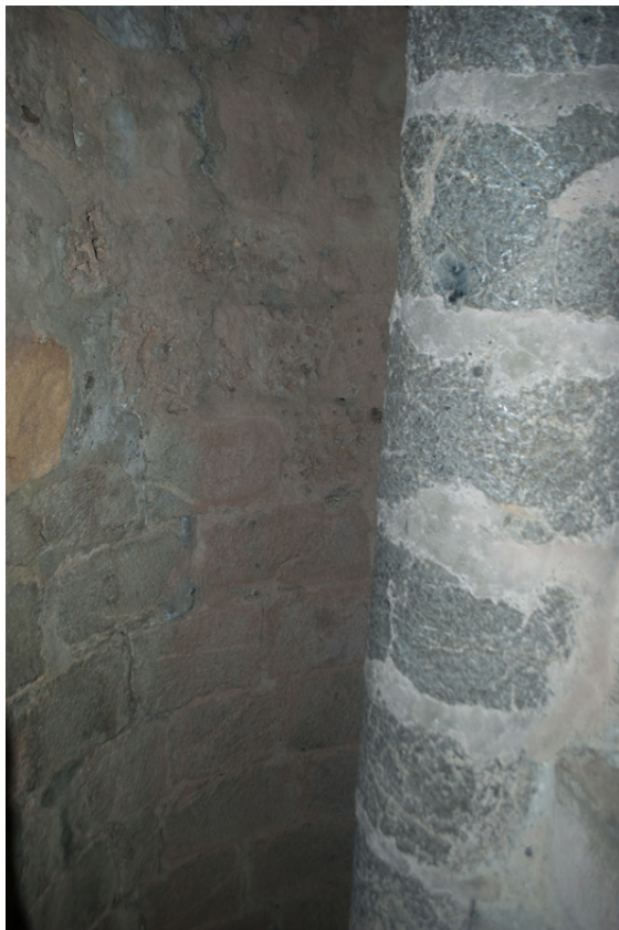
Figure 94 : Fin du parement roman de la cage d'escalier, reconstruction (XIXe siècle?) en assises irrégulières et joints beurrés.
