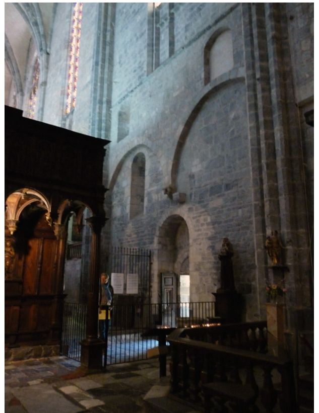
Figure 66 : 3ème travée, mur gouttereau sud.
