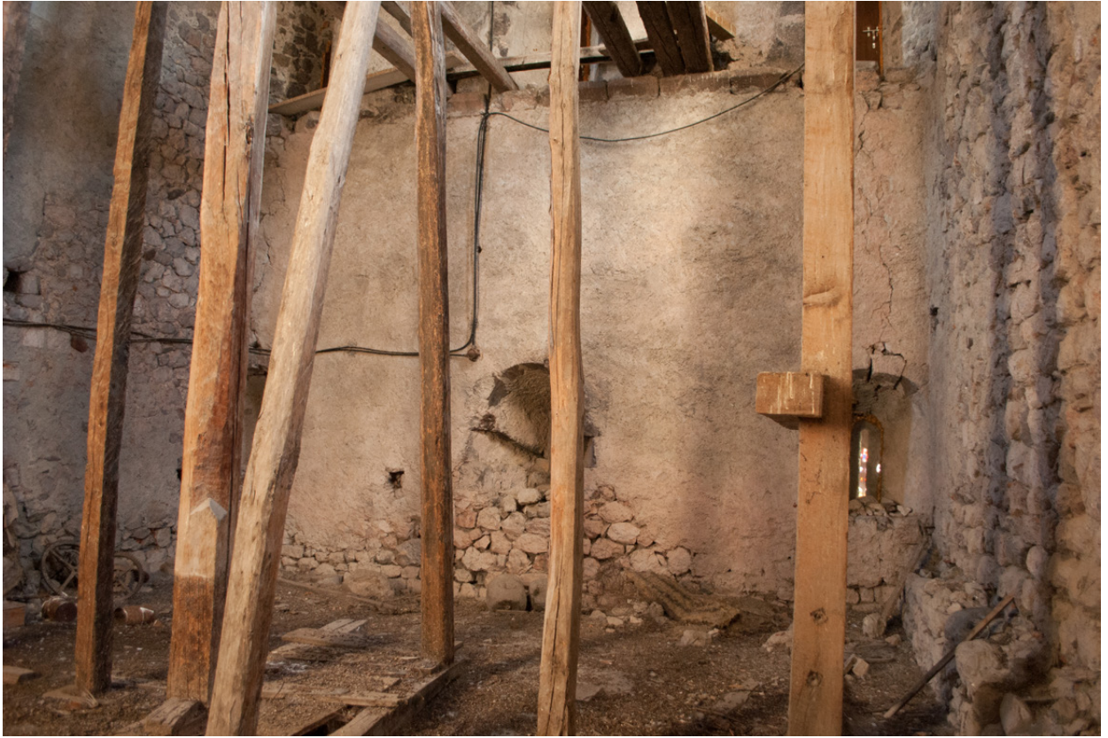
Figure 96 : Salle haute, mur est : jours inférieurs.
