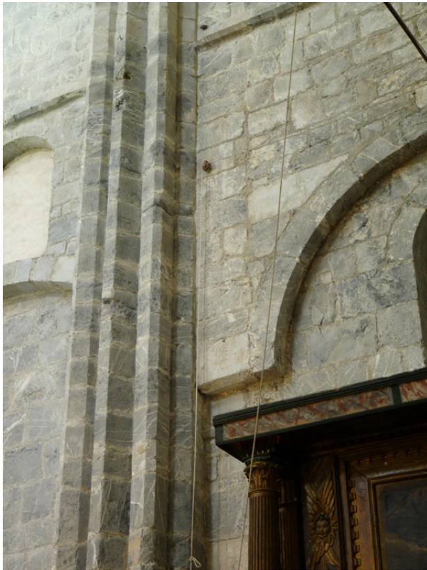
Figure 71 : 2ème travée, mur gouttereau sud : retombée de l'arc oriental, trace d'imposte en partie haute.
