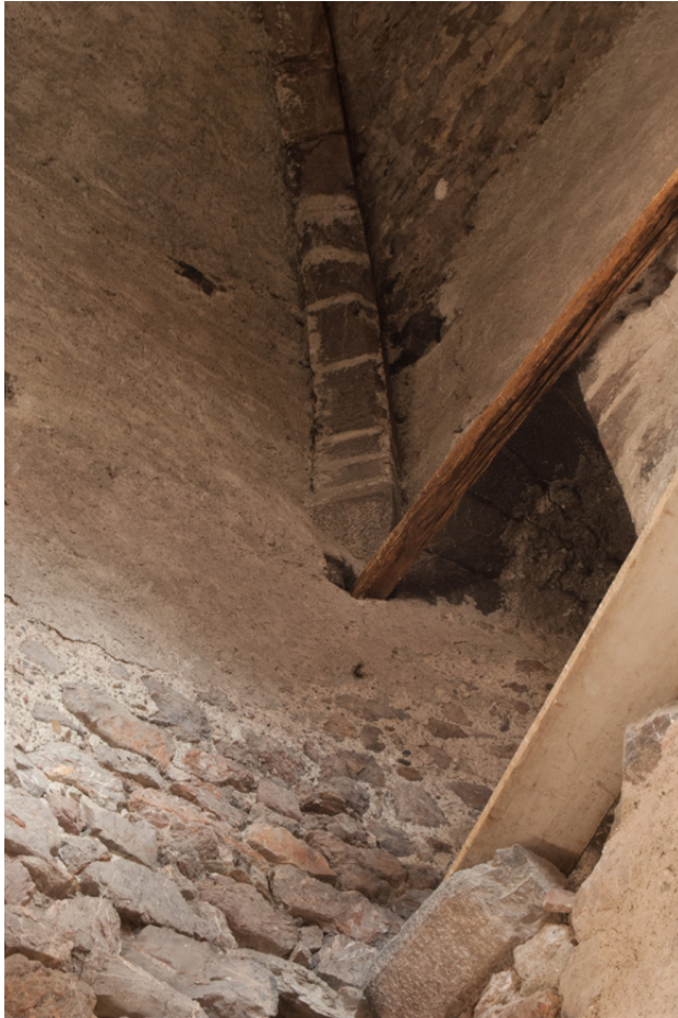
Figure 100 : Salle haute, mur nord : parement rejointoyé avec mortier à petits cailloux.
