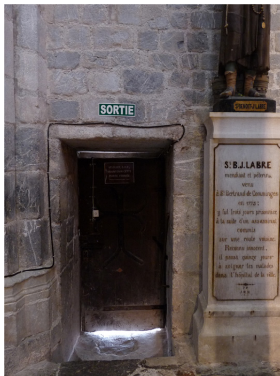
Figure 75 : 3ème travée, mur gouttereau nord : porte moderne.
