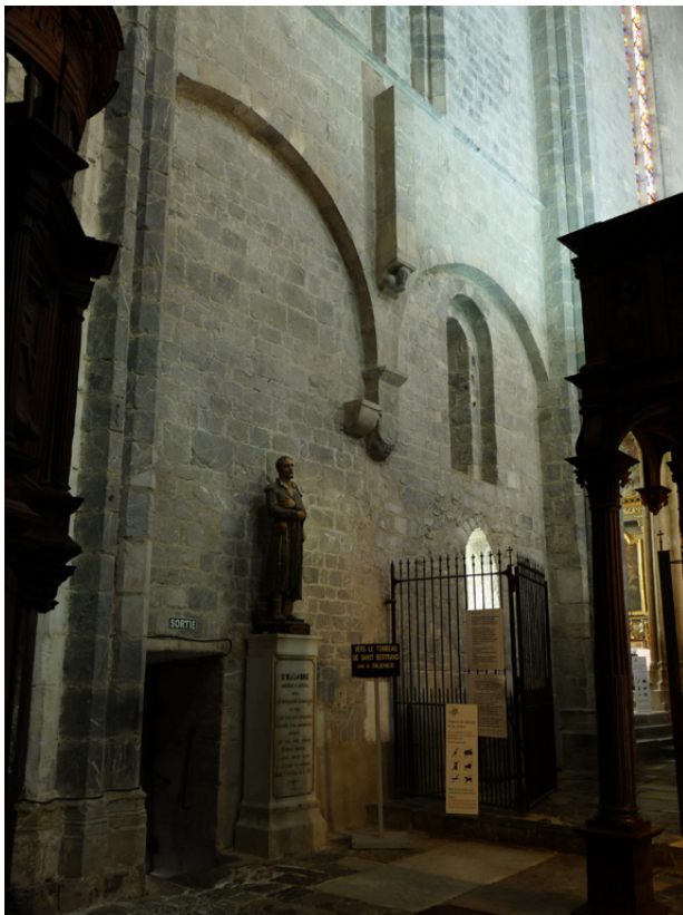
Figure 65 : 3ème travée, mur gouttereau nord.
