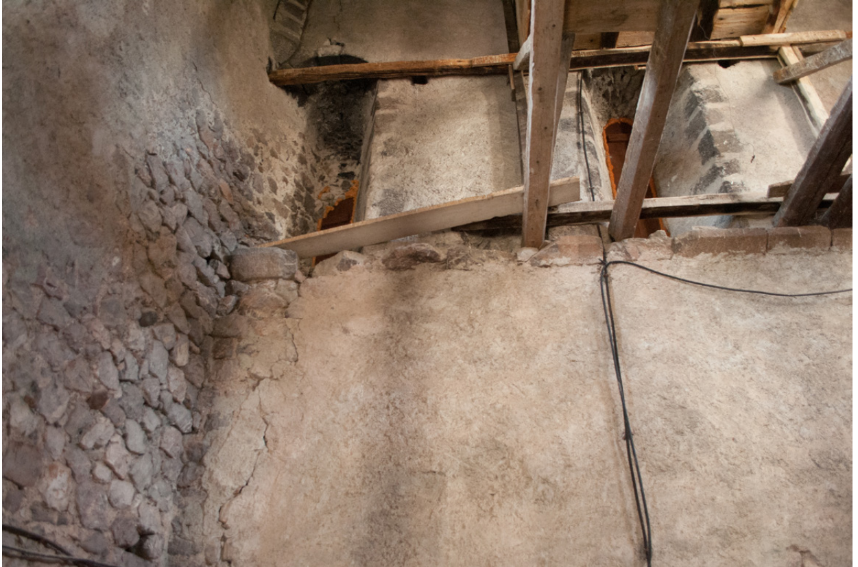
Figure 97 : Salle haute, mur est : archères supérieures et bandeau d'appui.
