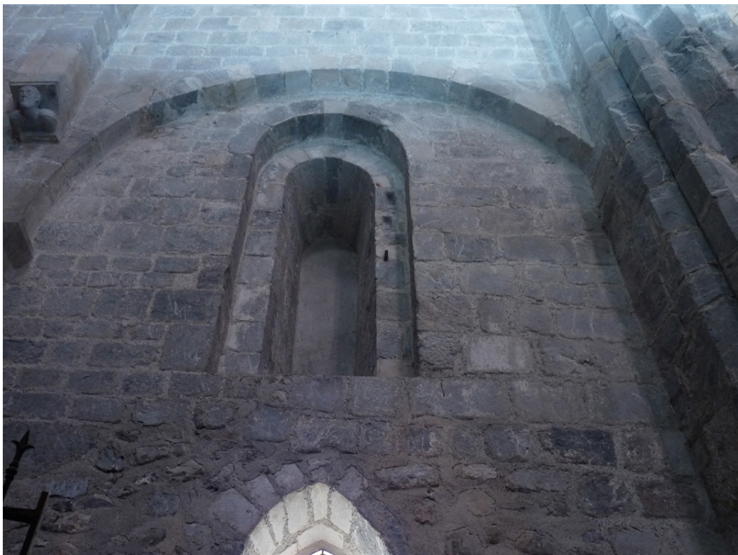
Figure 77 : 3ème travée, mur gouttereau nord : baie en plein cintre murée sous l'arc oriental.
