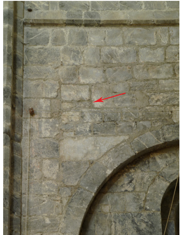
Figure 71 : 2ème travée, mur gouttereau sud : retombée de l'arc oriental, trace d'imposte en partie haute.
