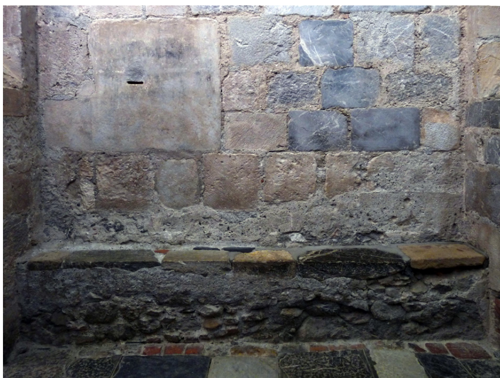
Figure 22 : Mur sud de la 4ème travée : banquette diminuée en hauteur et bûchage enduit.
