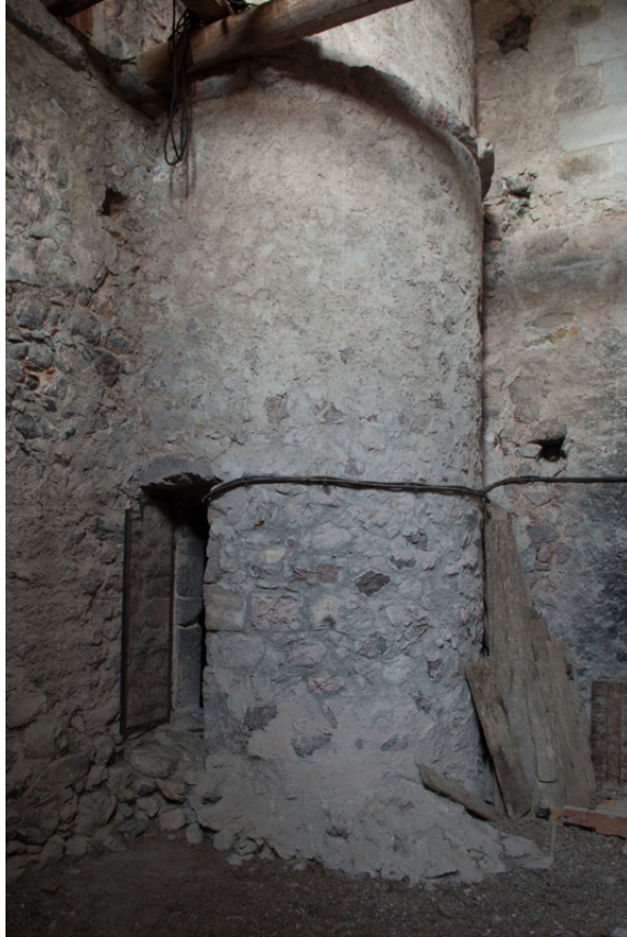
Figure 93 : Cage d'escalier dans la salle haute.
