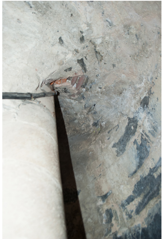
Figure 87 : Escalier du clocher : voûte hélicoïdale portant les marches.
