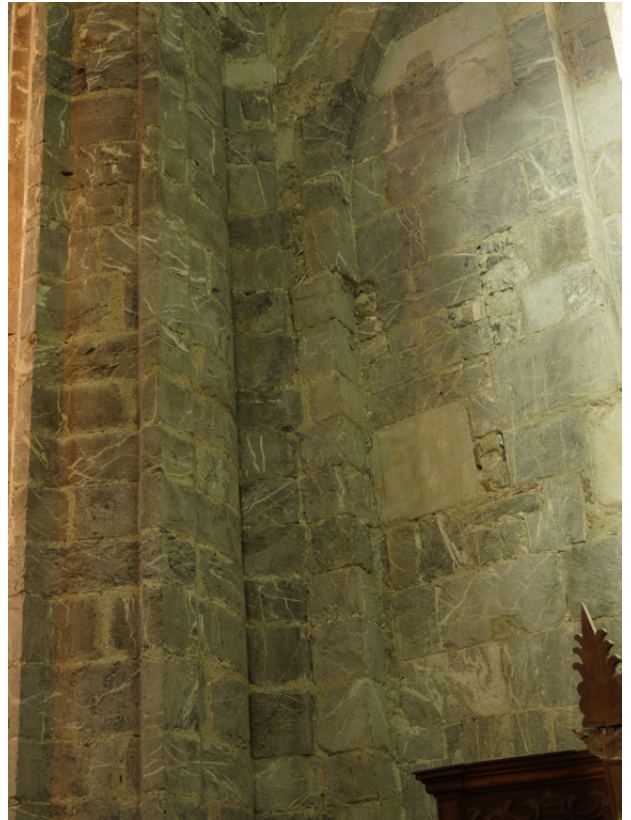
Figure 68 : 1ère travée, mur gouttereau sud : ressaut oriental de l'arcature.
