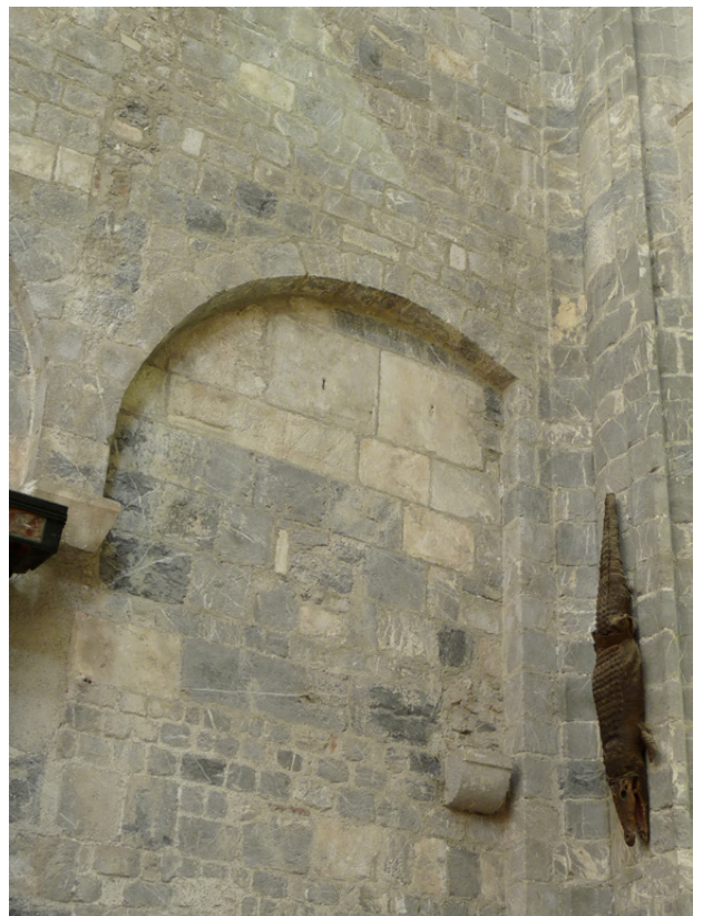
Figure 70 : 2ème travée, mur gouttereau sud : ressaut occidental de l'arcature.
