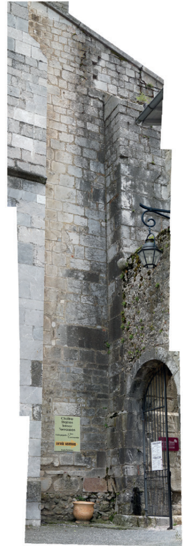
Figure 31 : Relevé de la façade ouest : mur pignon sud, relevé avec pierres antiques et trous de boulins, et photo-montage sans échelle. (DAO : Oriane Pilloix, 2016).
