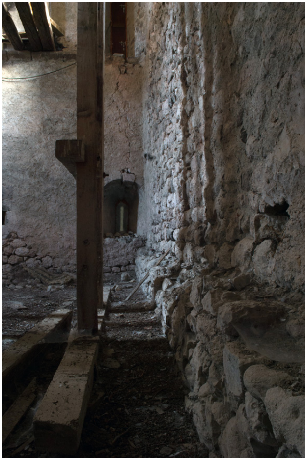
Figure 100 : Salle haute, mur nord : parement rejointoyé avec mortier à petits cailloux.
