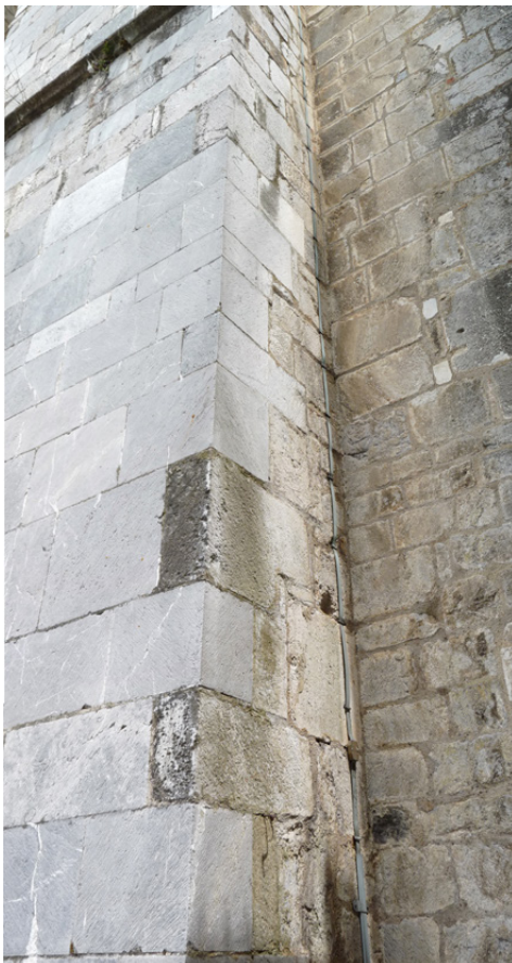
Figure 32 : Angle et détail du chaînage entre le mur pignon sud et le ressaut de la façade du clocher. Photomontage.
