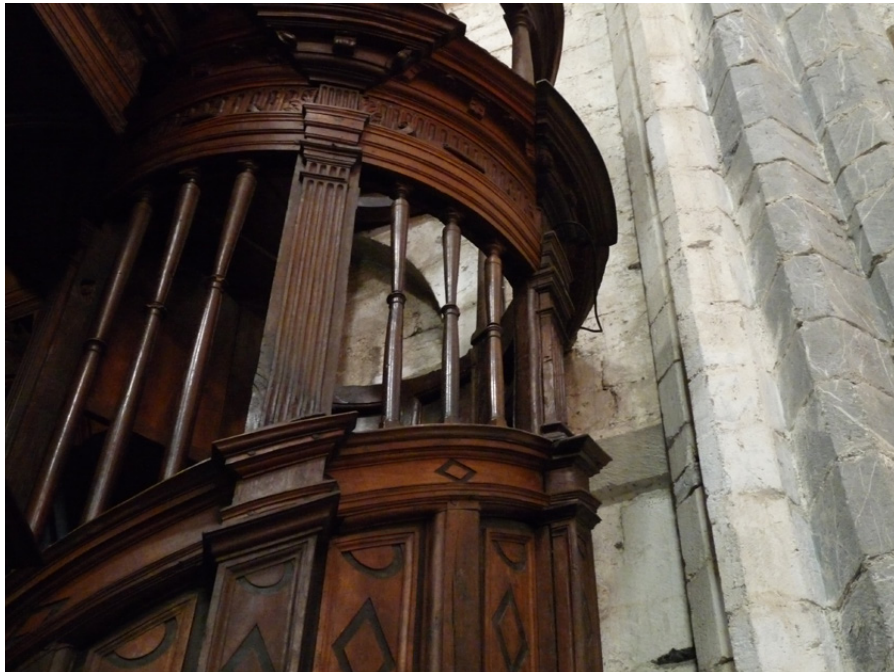
Figure 72 : 2ème travée, mur gouttereau nord : détail de la retombée de l'arcature orientale derrière l'escalier de l'orgue.
