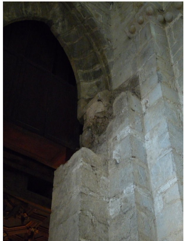
Figure 81 : 1ère travée, pilier à ressauts nord : détail du pilastre coupé pour l'insertion de l'arc en lancette gothique.
