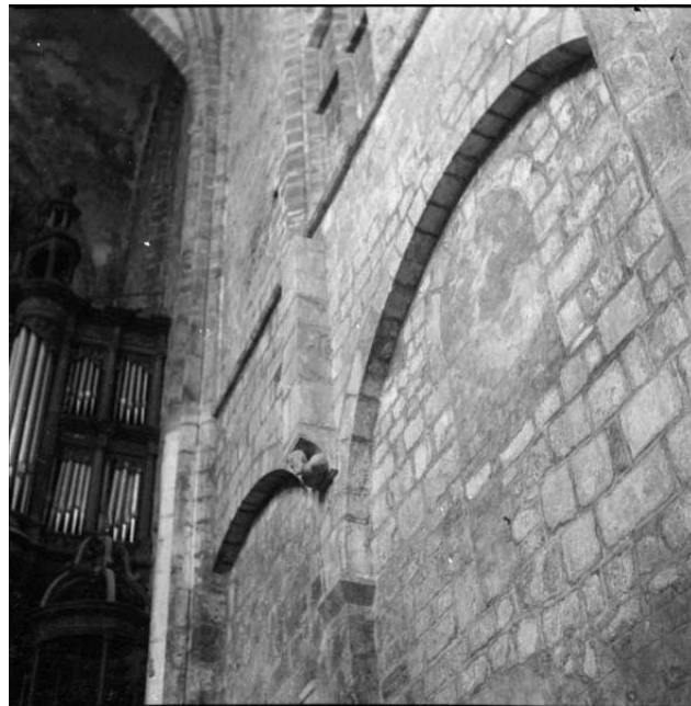
Figure 15 : Mur sud de la 3ème travée : baie murée, avant restauration. Photographie de Sylvain Stym-Popper, n°44L04538, MAP.
