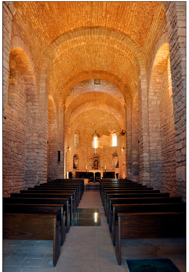
Figure 134 : Église Sant Ponç de Corbera de Llobregat (Espagne) : vue de la nef. (crédit : PCB75, Wikipédia)
