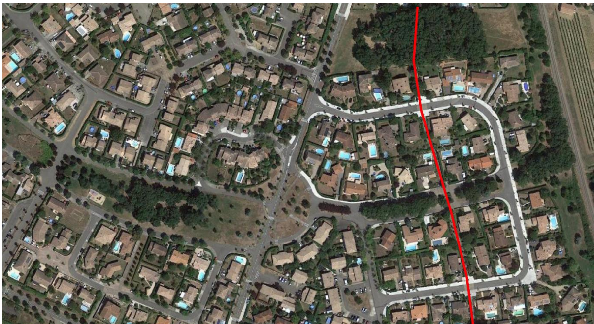
Figure 15 : Image satellite des « passages malins » de la commune de Colomiers (en rouge) (Source : Google Maps).
