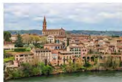
Albi - La Madeleine un quartier de faubourg avec beaucoup de maisons individuelles construites avant 1950
