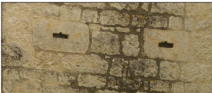
Figure 13 : Exemple de canonnière plate de l'époque moderne
