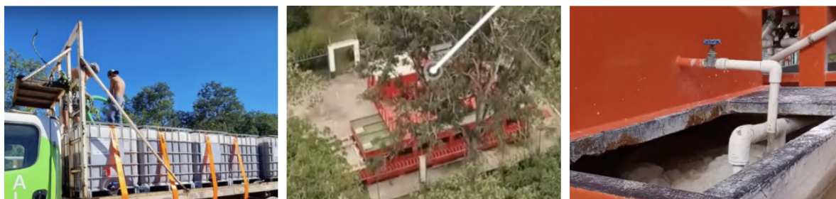
Figure 7 – Dispositif mobile de traitement des eaux usées testé par Hurakaan Eco-Táctica en partenariat avec l'entreprise TIDIP 40
