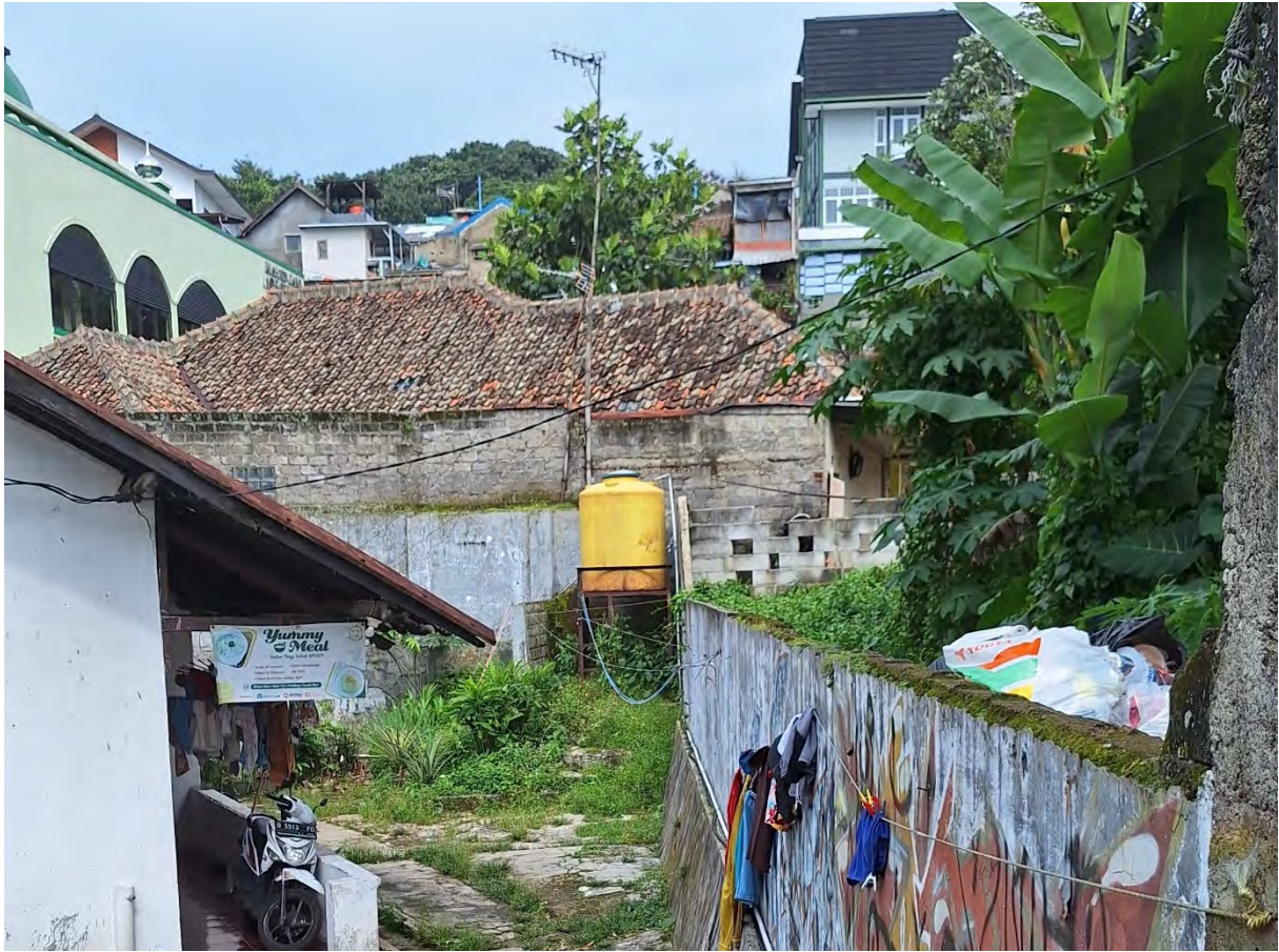
Photographie 2 : Réservoir dans la cour d'une habitation située dans le quartier de Ciumbuleuit. Source : auteur (2024).
