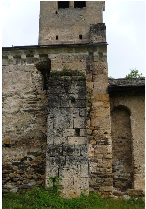
Fig. 80 : Contrefort et mur dans l'axe du clocher coup de sabre entre les deux appareils
