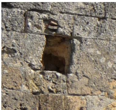
Fig. 81 : Trou pour l'ancienne poutre faîtière
